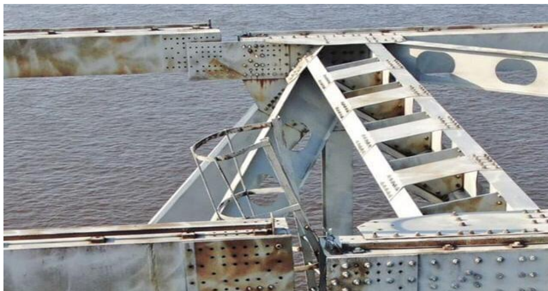
Рис. 2. Обследование моста с помощью БПЛА обычным пользователем
