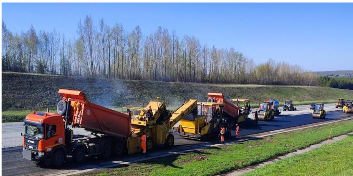
Рис. 3. Машины и механизмы при устройстве покрытия из асфальтобетонной смеси марки SP-16Т
