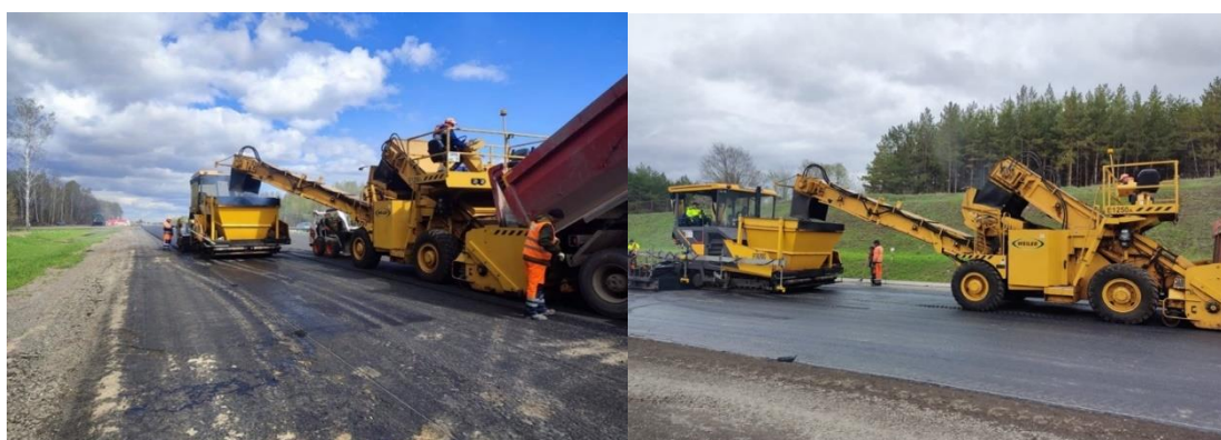
Рис. 2. Выгрузка асфальтобетонной смеси в перегружатель Weller E1250A
