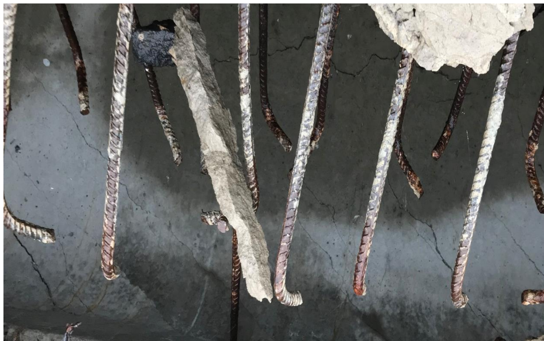
Рис. 1. Сетка трещин на балке пролетного строения
