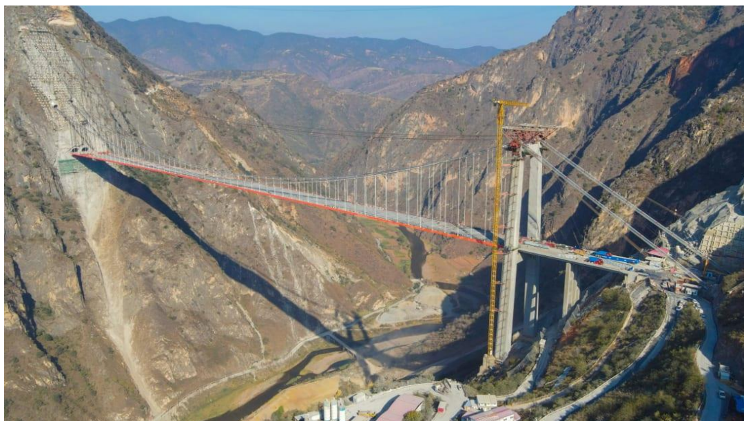
Рис. 2. Строительство висячего моста в горных условиях (Источник: https://edition.cnn.com/travel/article/lvzhijiang-yunnan-china-suspension-bridge/index.html )
