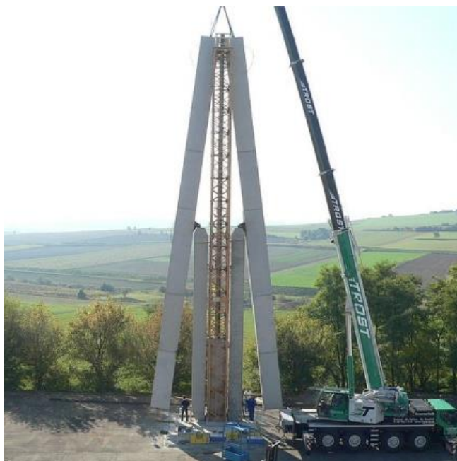
Рис. 3. Начальная стадия возведения «зонтичного» моста на р. Ланбах, Австралия (Источник: https://www.betonbau.tuwien.ac.at/forschung/aktuelle-forschungsprojekte/fotogalerie-gars-am-kamp/ )
