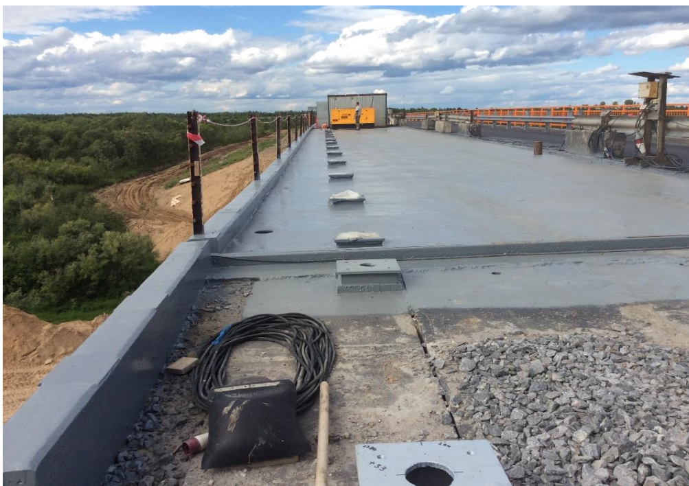
Рис. 1. Пример применения гидроизоляции ООО НПФ «Современные покрытия»
