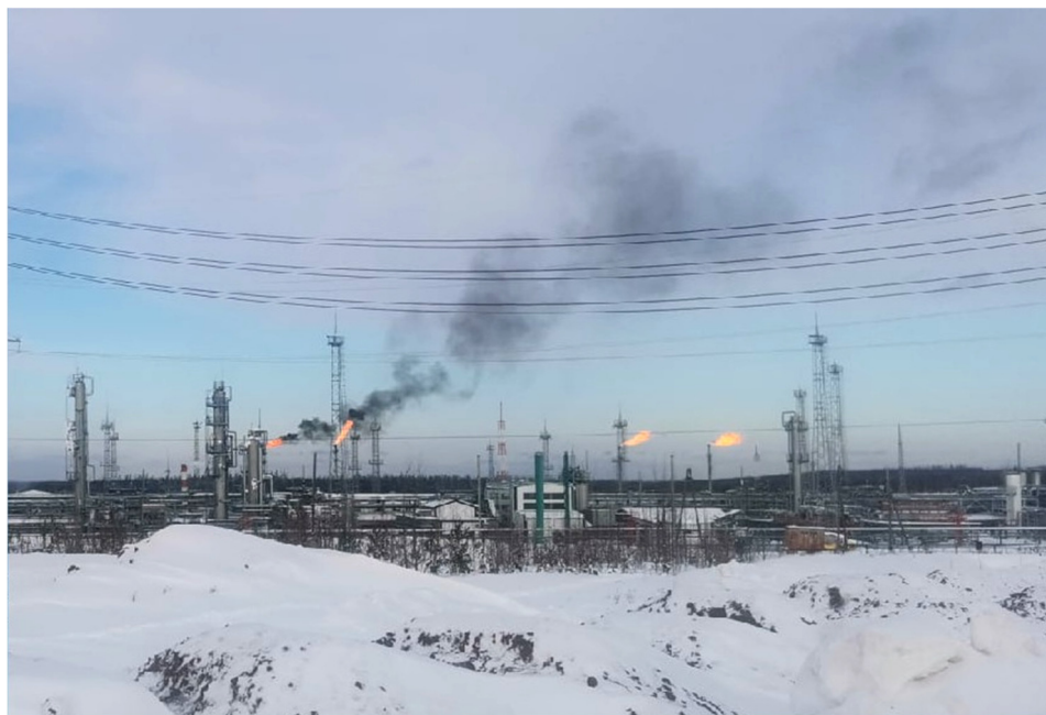
Рис. 4. Копчение факела на НПЗ, вызванное нарушением режима горения
