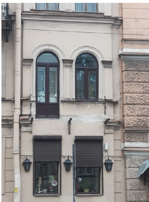
Рис. 13. Лермонтовский пр., д. 26. Демонтаж балконной плиты и балконного ограждения
