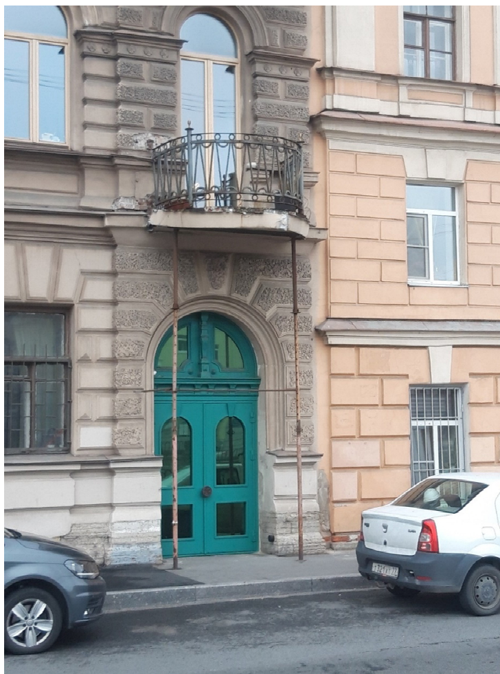
Рис. 15. Наб. реки Фонтанки, д. 139. Установка временных опор
