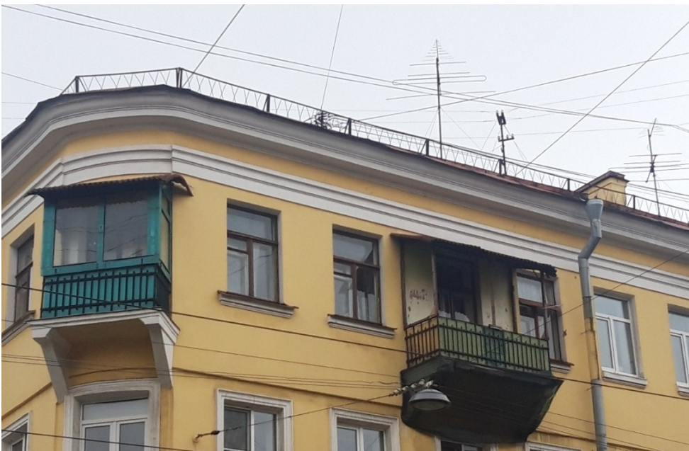
Рис. 16. Влияние остекления на эксплуатационную надежность балконных конструкций
