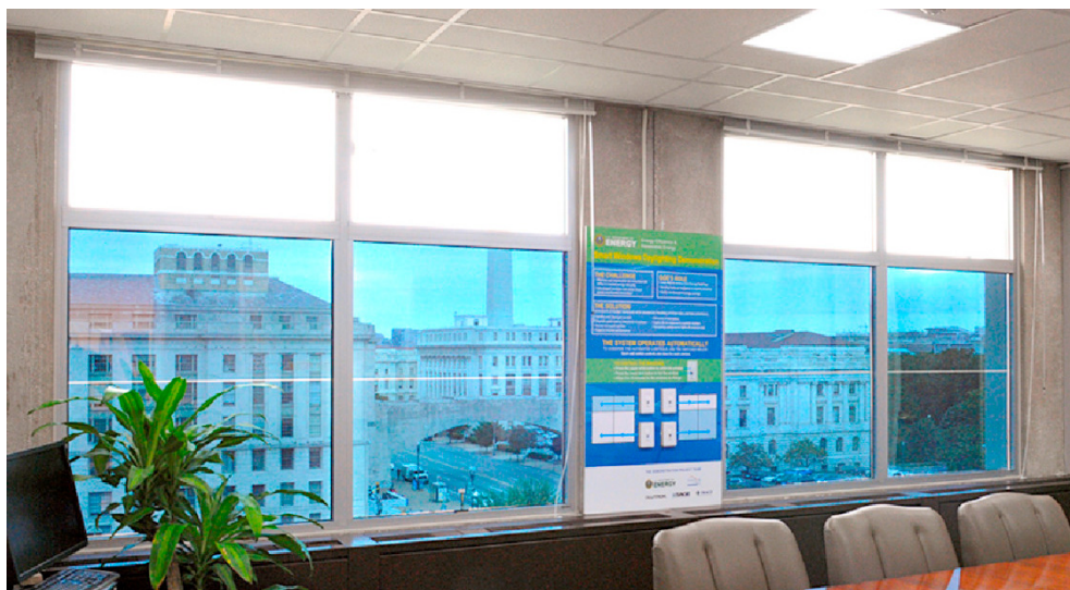
Рис. 1. Электрохромное остекление с верхней и нижней зонами управления [11]
