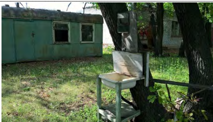
Рис. 5. Существующее состояние жилых корпусов
