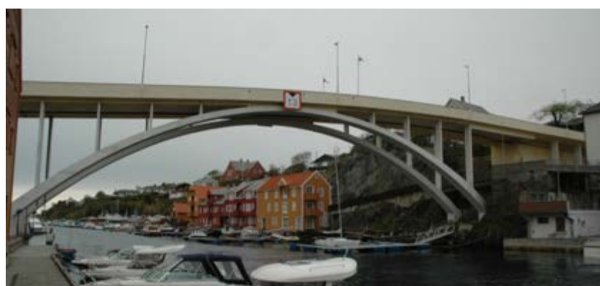
Рис. 2. Арочный мост в Норвегии
