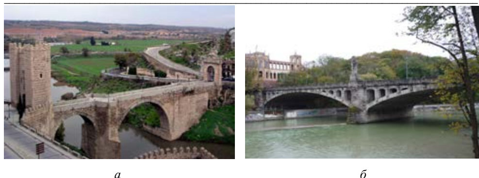
Рис. 1. Мост: а — со сплошной надарочной частью; б — с поперечными стенками
