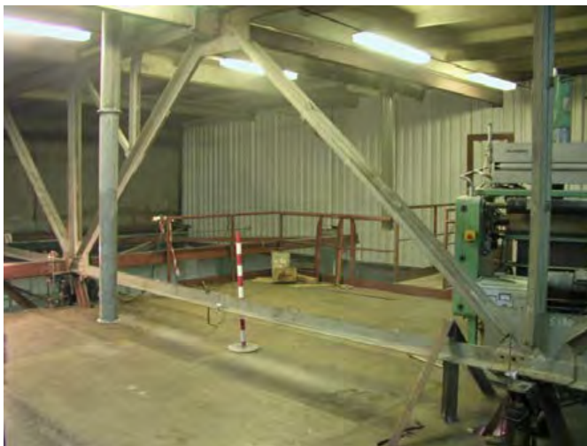
Рис. 5. Подготовительные работы для подъема фермы
