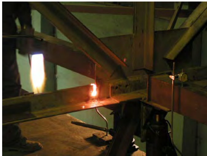
Рис. 6. Демонтаж нижнего пояса фермы
