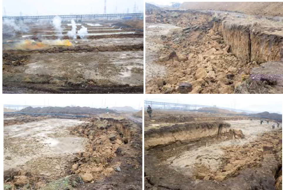
Рис. 2. Гидровзрывное уплотнение просадочных лессов на площадке строительства Газоперерабатывающего завода в г. Буденновске Ставропольского края
