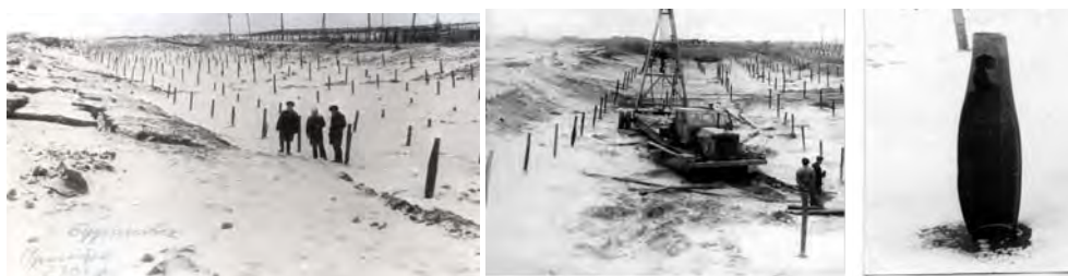
Рис. 1. Просадка грунта после гидровзрывного уплотнения лесса мощностью 28 м в г. Буденновске (декабрь 1976 г.) и неудачная попытка выдернуть обсадные трубы, разорванные после взрывов
