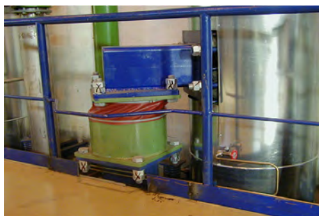
Рис. 8. Общий вид высоковязкого демпфера
