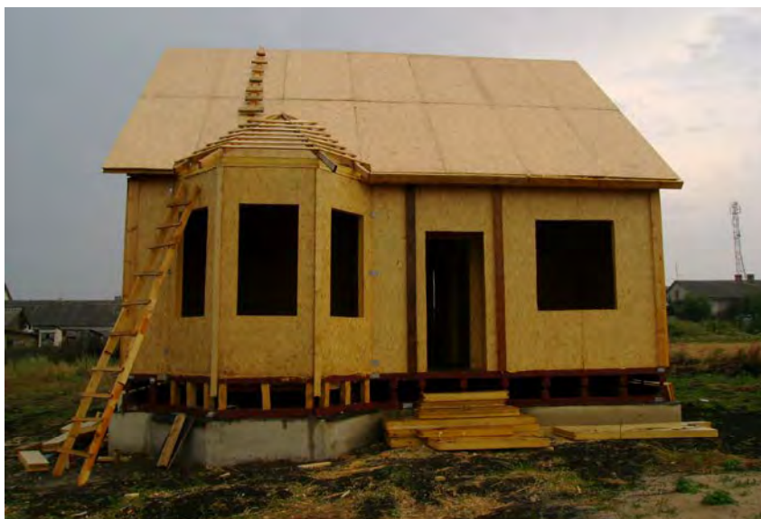
Строительство одноэтажного жилого дома при помощи сэндвич-панелей
