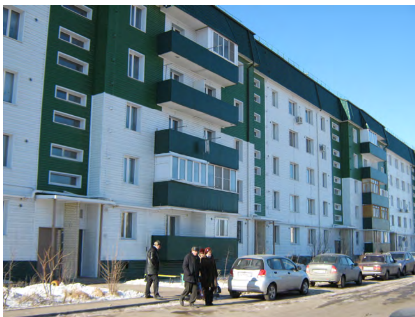
Рис. 1. Общий вид обследованного здания
