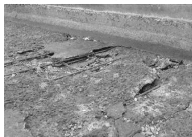
Рис. 2. Характерное разрушение облицовки дна лотка Чегемской ООС
