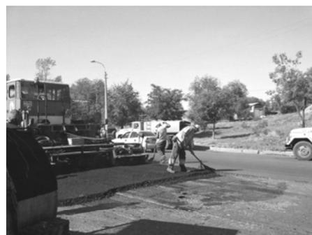
Рис. 3. Ремонт дорожного покрытия на ул. Электрослесовская (асфальтоукладчик ДС-191-506)
