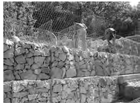
Рис. 2. Габионные устройства
