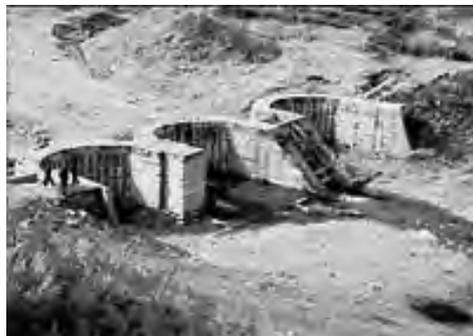
Рис. 1. Противоселевая плотина из сборного железобетона
