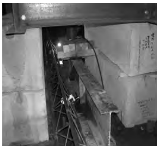
Рис. 7. Испытание ленточного фундамента подкрепленного микросваями
