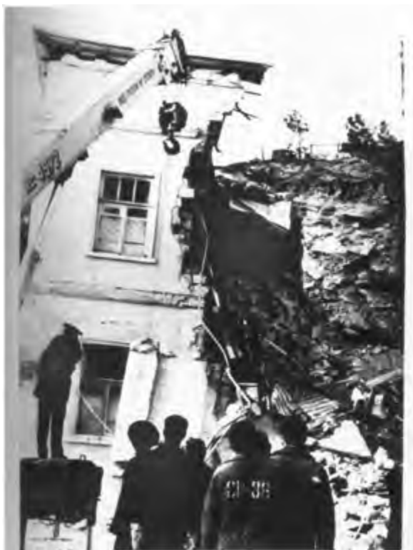
Рис. 5. Сохранившаяся часть здания столовой
