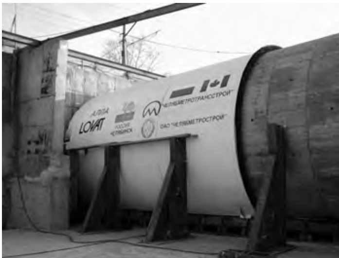
Рис. 2. Старт тоннелепроходческого комплекса марки RME 222 SE из открытого котлована
