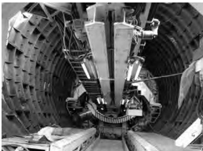
Рис. 4. Общий вид тубинговой обделки
