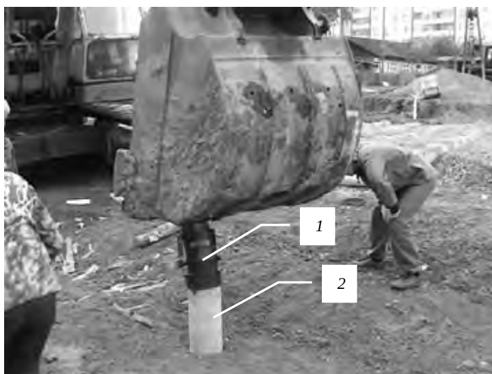
Рис. 1. Процесс вдавливания свай: 1 — гидравлический домкрат; 2 — вдавливаемая микросвая
