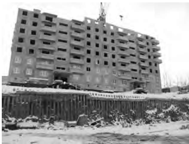
Рис. 2. Фрагмент подпорной стены и здания
