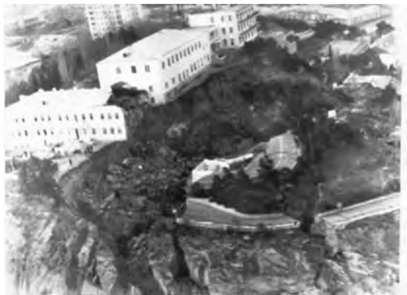
Рис. 3. Вид на верхнюю часть оползня с восточной стороны
