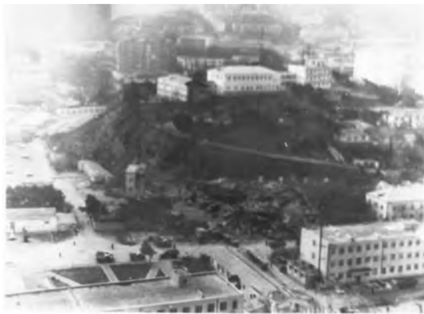
Рис. 2. Общий вид оползня с северо-восточной стороны
