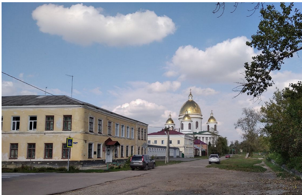
Рис. 2. Ансамбль ул. Свободной. Троицкий собор. Современный вид
