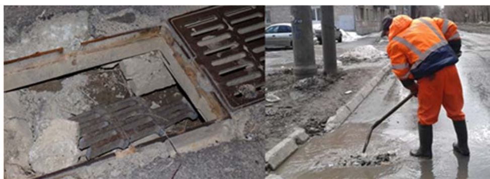
Рис. 3. Очистка заваленных мусором дождеприемных колодцев
