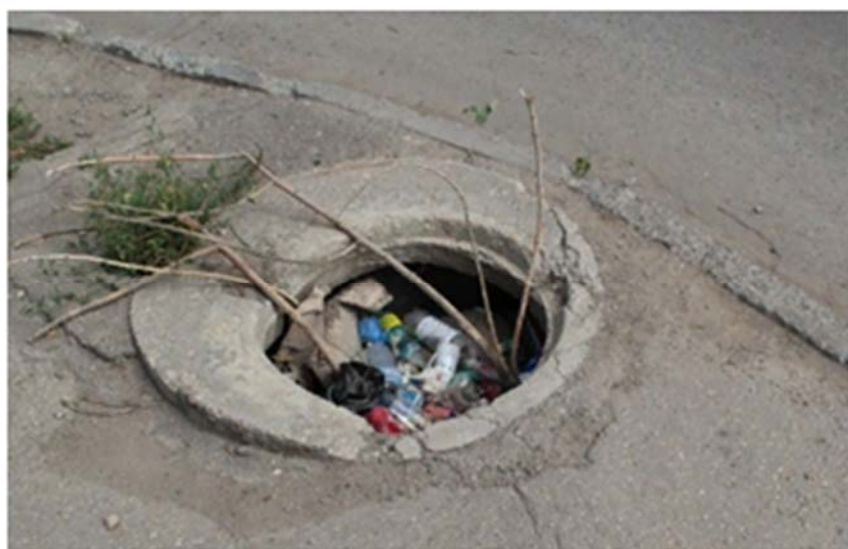
Рис. 2. Засоренный смотровой колодец
