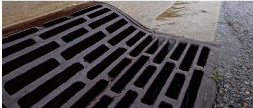
Рис. 7. Прибордюрный лоток, совмещенный с дождеприемником
