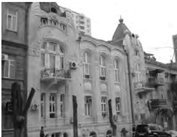
Рис. 1. Здание жилого дома К. И. Гаджиева
