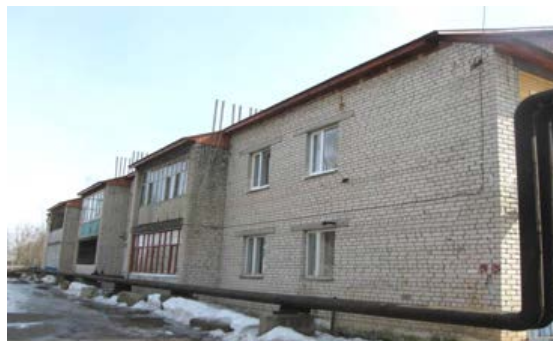
Рис. 3. Общий вид исследуемого здания
