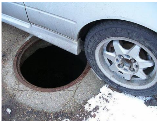
Рис. 11. Открытые люки дождеприемных колодцев
