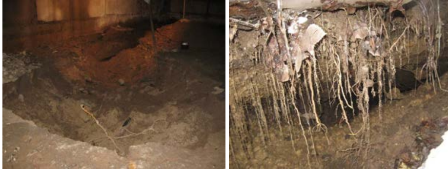
Рис. 4. Карстовые провалы в подвале дома
