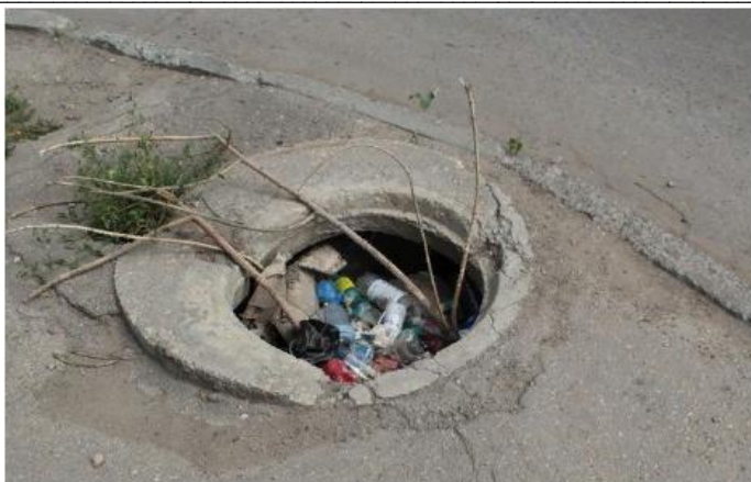
Рис. 8. «Замусоренный» смотровой колодец
