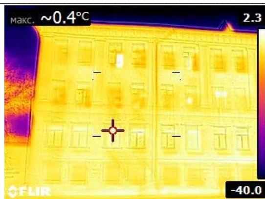
Рис. 1. Термограмма участка фасада объекта обследования
