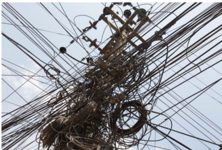
Рис. 1. Внешний вид опоры линий электропередач в г. Нижнем Тагиле, 2016 год
