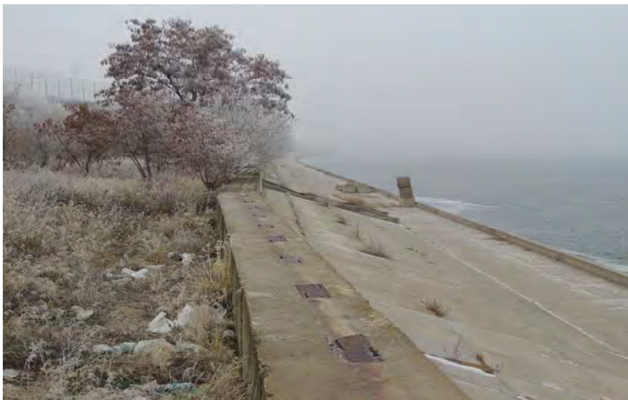
Рис. 5. Общий вид берегоукрепления набережной Нижнего поселка Волгоградского тракторного завода г. Волгограда
