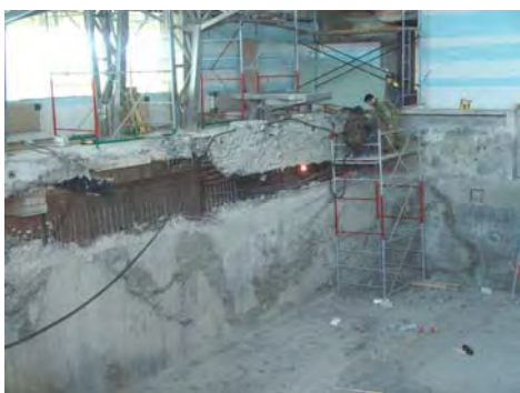
Рис. 1. Демонтаж дефектной зоны передней стенки ванны бассейна
