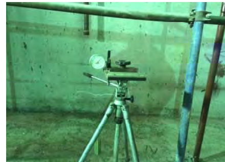
Рис. 8. Общий вид прогибомера (точка 1)
