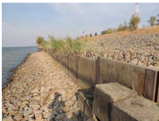
Рис. 1. Старая очередь берегоукрепительных сооружений
