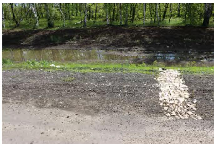
Рис. 9. Поперечная дренажная прорезь на участке избыточного увлажнения насыпи
