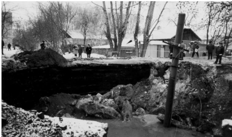
Рис. 1. Провал дорожного полотна
