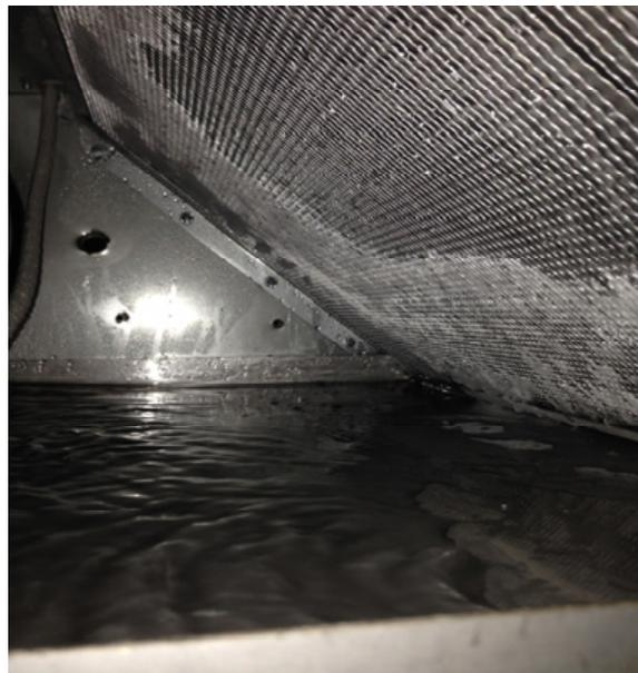
Рис. 2. Рекуператор в режиме оттаивания
