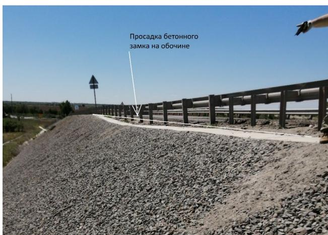
Рис. 9. Просадка бетонного замка на обочине насыпи
