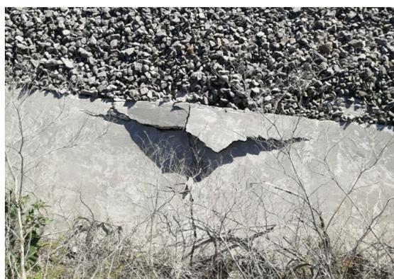
Рис. 7. Разрушения бетонной стенки водоотводной канавы
