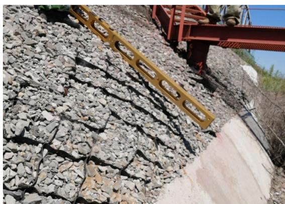
Рис. 6. Нависание грунтового массива с георешеткой над водоотводной канавой
