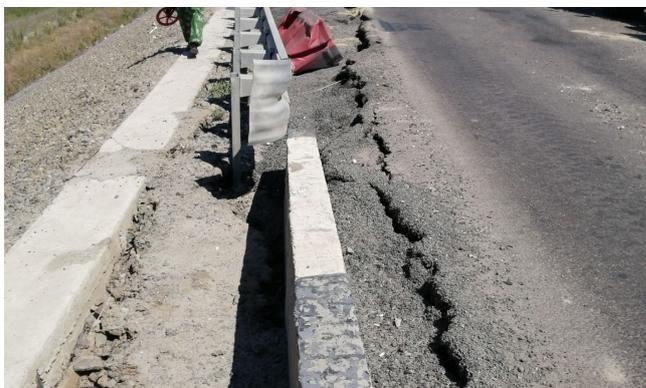
Рис. 3. Просадки обочины и проезжей части
