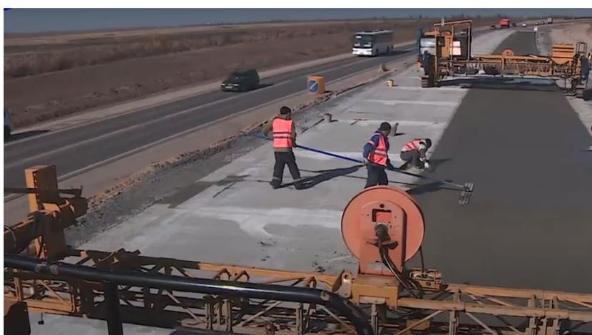
Рис. 6. Ручная отделка цементобетонного покрытия
