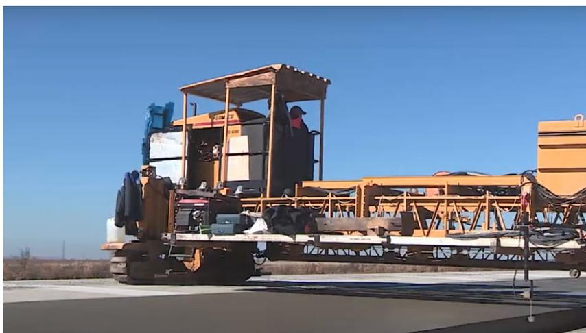
Рис. 5. Укладка смеси бетоноукладчиком GOMACO GHP-2800
