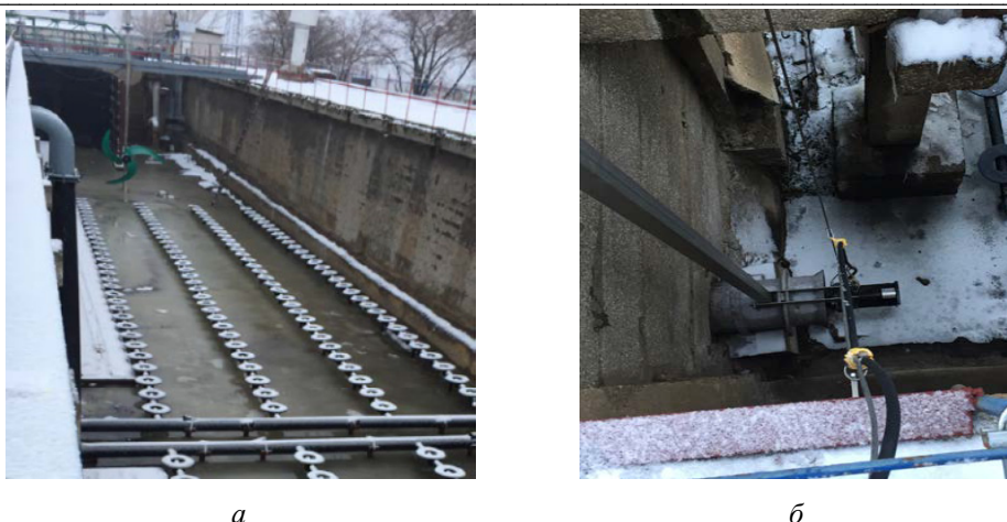
Рис. 2. Результаты мероприятий по интенсификации аэротенка блока № 2 ГКОС, Волгограде, о. Голодный: а — зона аэрация, оборудованная мешалкой WILO TRE 326-3.37-4/8; б — насос, обеспечивающий рецикл активного ила WILO RZP 40.95-6/24 S5
