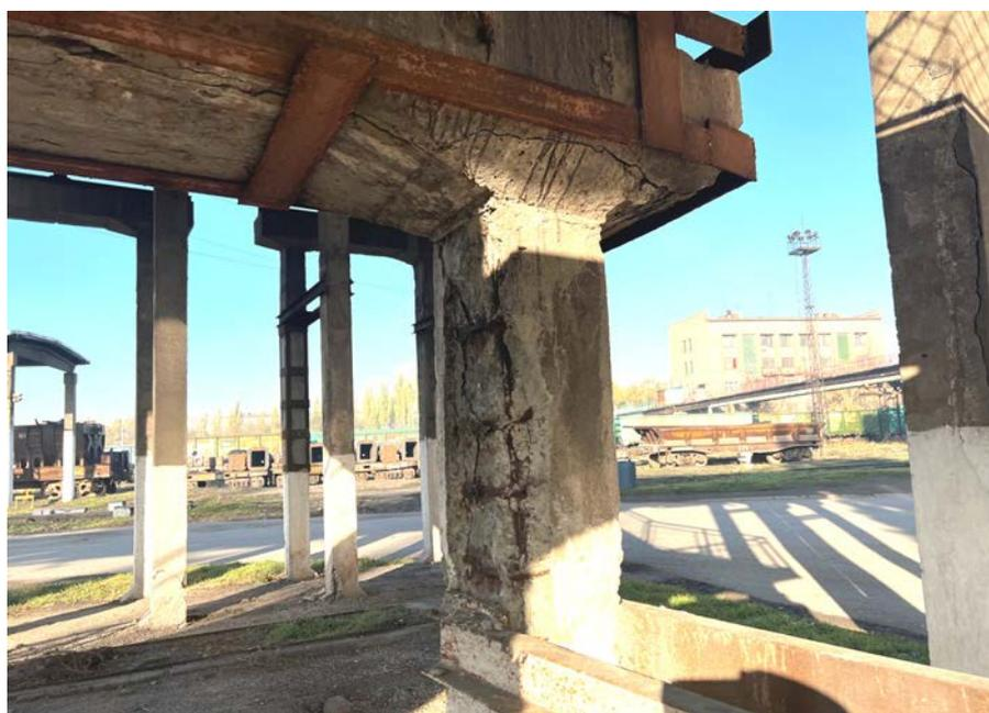
Рис. 3. Деструкционные повреждения железобетонной опоры лестничного хода
