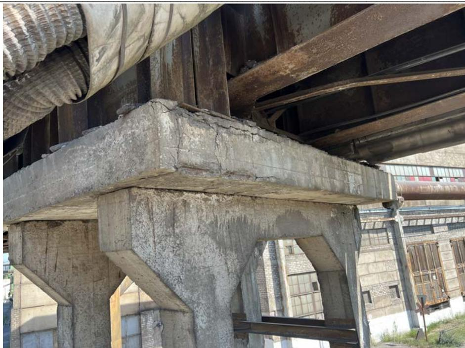
Рис. 4. Деструкционные повреждения опорной железобетонной плиты пролетного строения
