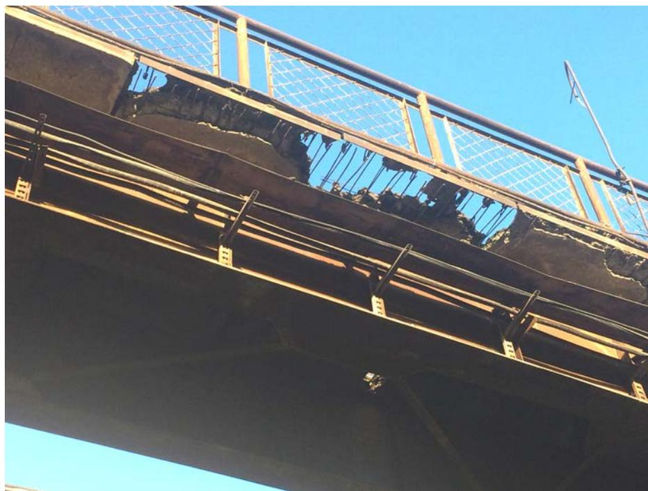
Рис. 5. Критические повреждения плит покрытия эстакады
