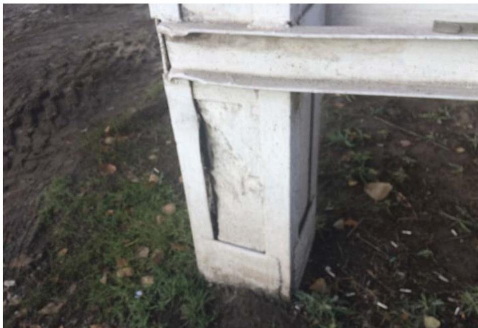
Рис. 8. Усиление железобетонных опор пешеходной эстакады
