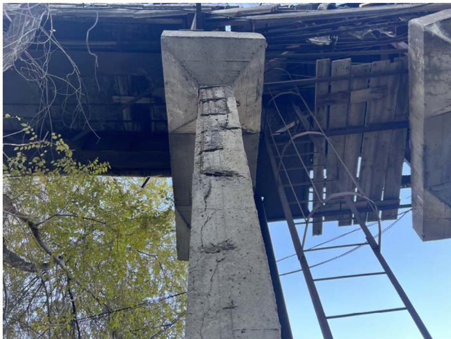
Рис. 2. Деструкционные повреждения железобетонной опоры пролетного строения
