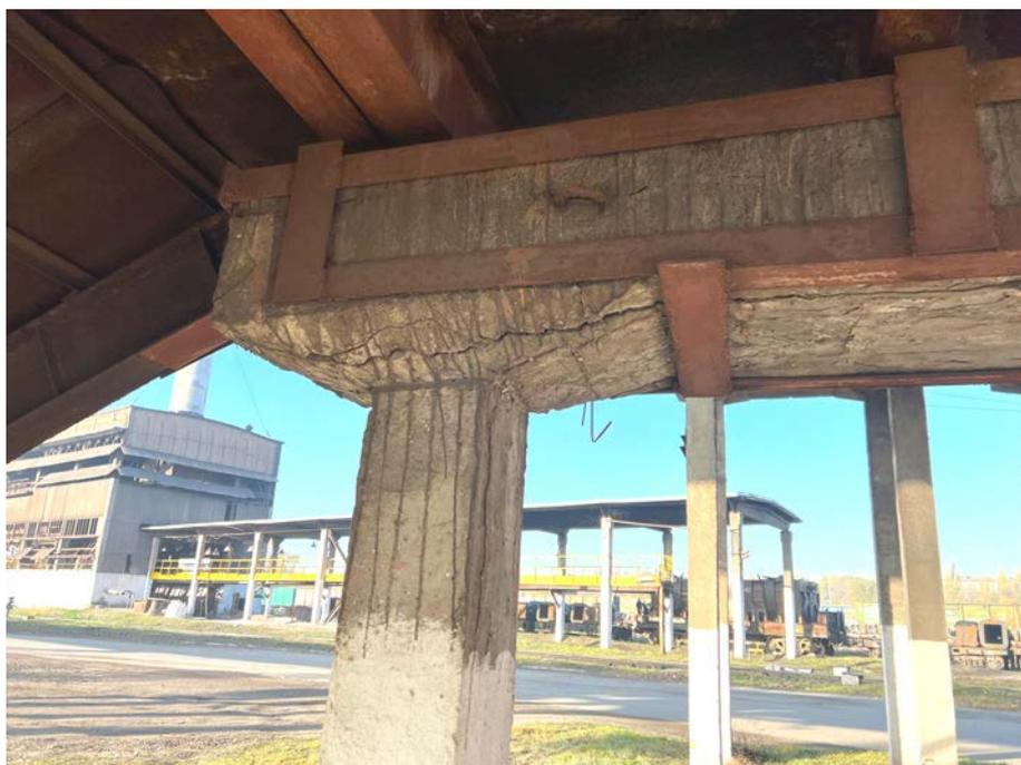
Рис. 10. Разрушение усиленных железобетонных опор пешеходной эстакады
