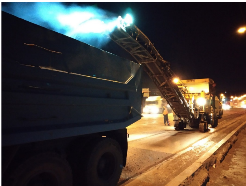
Рис. 2. Фрезерование старого покрытия на участке пр. Университетский — ул. Кабардинская г. Волгограда
