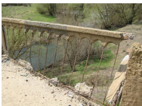
Рис. 1. Пролет 1. Верховая сторона. Блок 1. Перильное ограждение. Потеря устойчивости ограждения. Опасность обрушения
