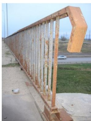
Рис. 3. Перильное ограждение. Сплошная коррозия металлической поверхности элементов конструкции
