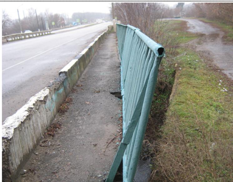
Рис. 5. Крен конструкции перильного ограждения. Потеря вертикальности и устойчивости
