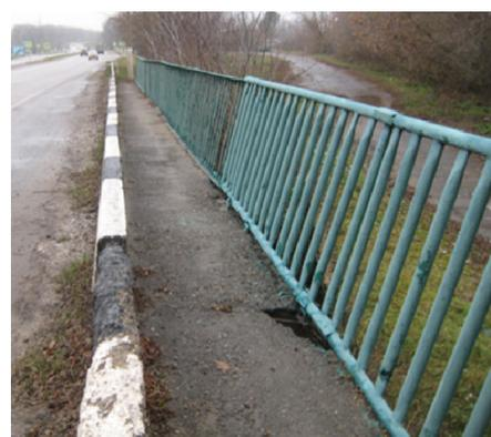
Рис. 4. Крен конструкции перильного ограждения. Разрушение крепления элементов к мостовому сооружению
