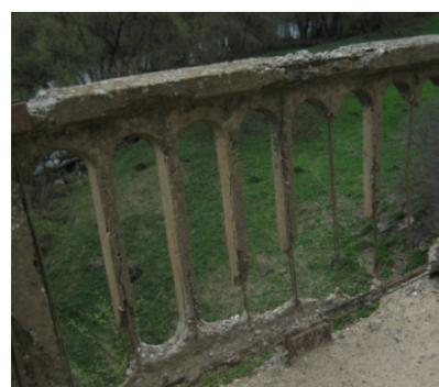
Рис. 2. Пролет 2. Низовая сторона. Перильное ограждение. Блок 14. Интенсивное разрушение бетона с обнажением арматуры
