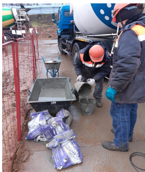
Рис. 2. Процесс получения бетонной смеси с гидроизоляционными добавками
