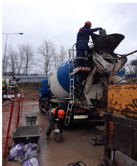
Рис. 2. Процесс получения бетонной смеси с гидроизоляционными добавками
