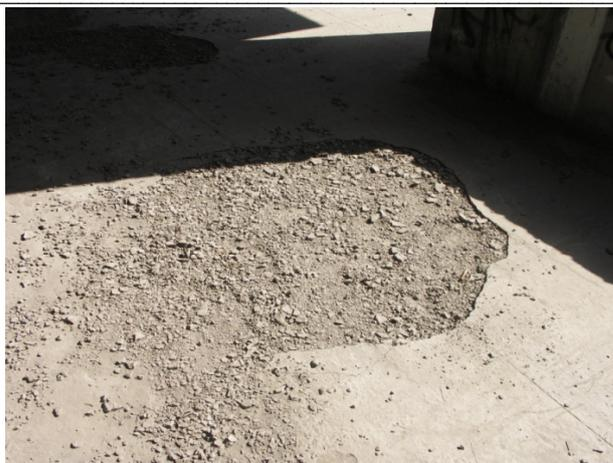
Рис. 2. Деструктивное повреждение монолитной плиты
