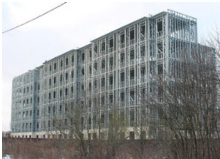
Рис. 2. Жилой дом, Калужская область, деревня Кривское
