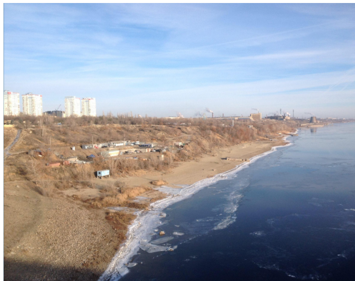
Рис. 5. Участок берегоукрепления до начала строительства
