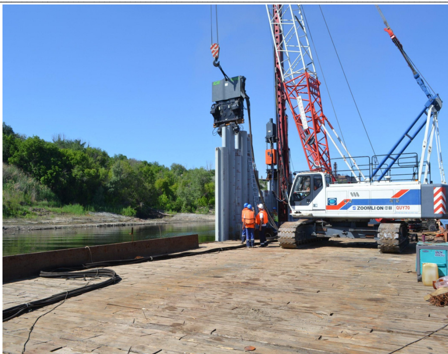
Рис. 6. Участок берегоукрепления во время строительства
