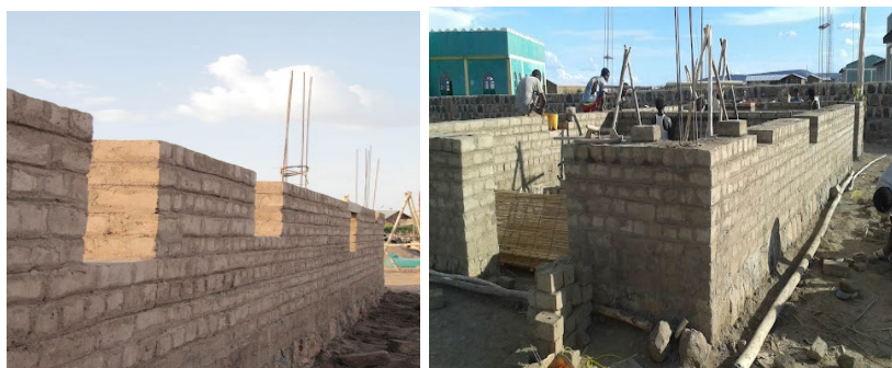
Рис. 2. Глиняные блоки в строительстве местного жилья
