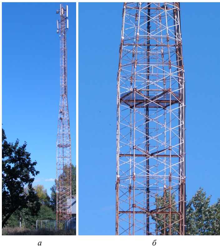
Рис. 1. Объект исследования. Башня H = 39,32 м: a — общий вид; б — фрагмент
