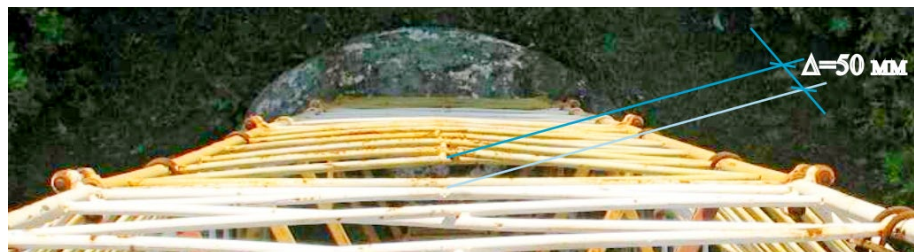
Рис. 2. Искривление граней третьей секции стрелкой до 50 мм
