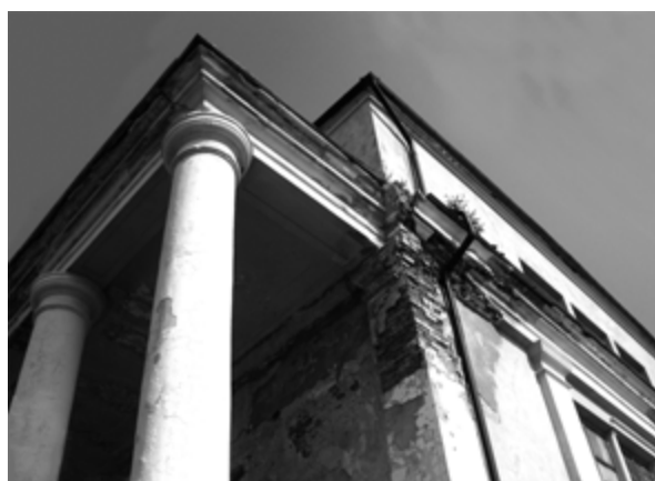
Рис. 4. Морозное отслаивание штукатурки и разрушение кирпичной кладки (фото)
