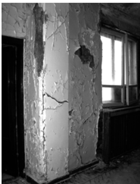
Рис. 5. Дефекты в несущих конструкциях (фото)
