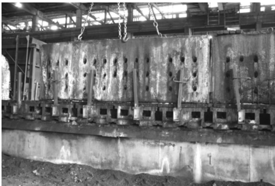
Рис. 1. Сборка щитов из жаростойкого композита
