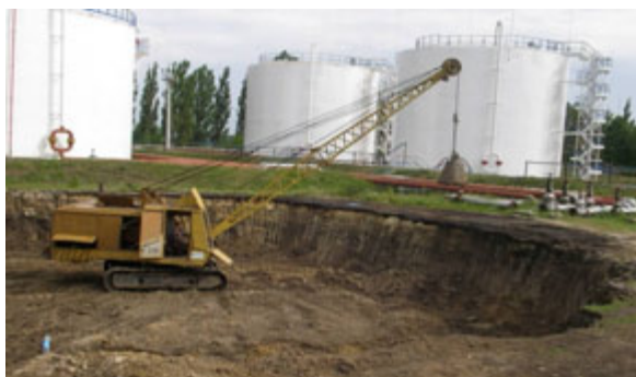
Рис. 1. Сооружение грунтовой подушки тяжелой трамбовкой под резервуар в с. Качаново Полтавской области (Украина)
