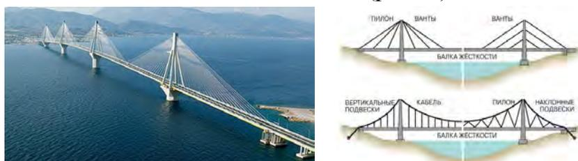
Рис. 4. Общий вид и схема вантового моста
