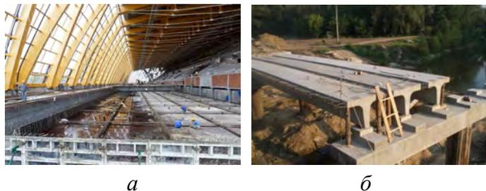
Рис. 8. Возведение монолитного каркаса и монтаж элементов сборных конструкций моста.
