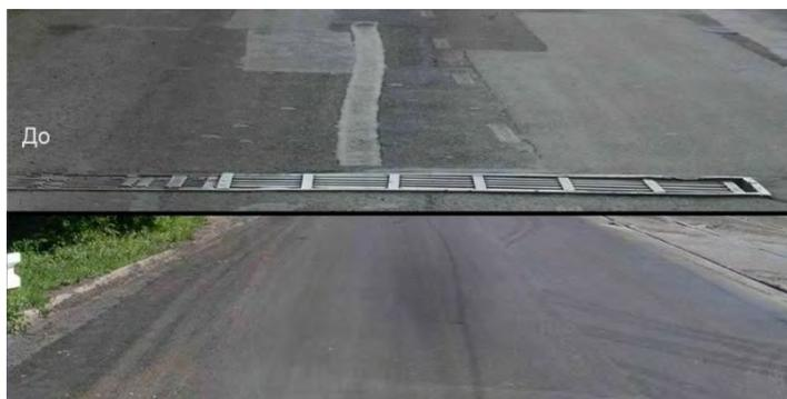
Рис. 1. Ремонт автомобильной дороги с применением технологии «Сларри Сил».
