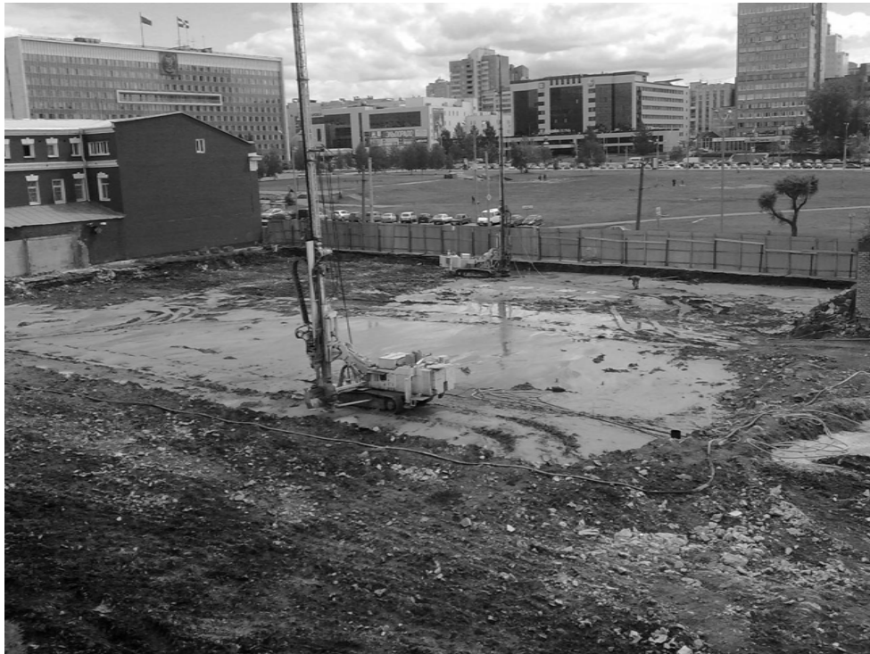
Рис. 2. Производство работ по устройству инженерной подготовки основания
