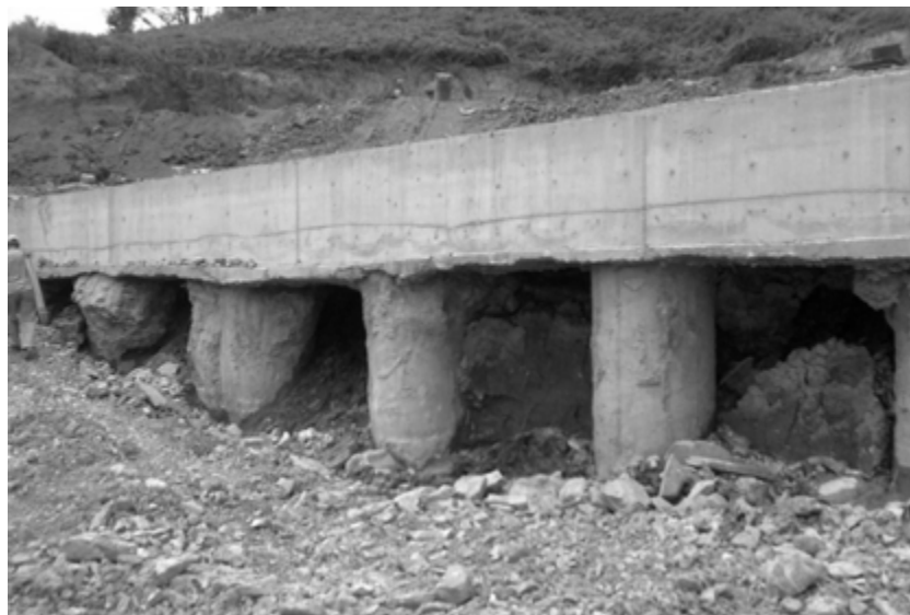
Рис. 2. Отрыв грунта от построенного удерживающего сооружения в верховой части оползня
