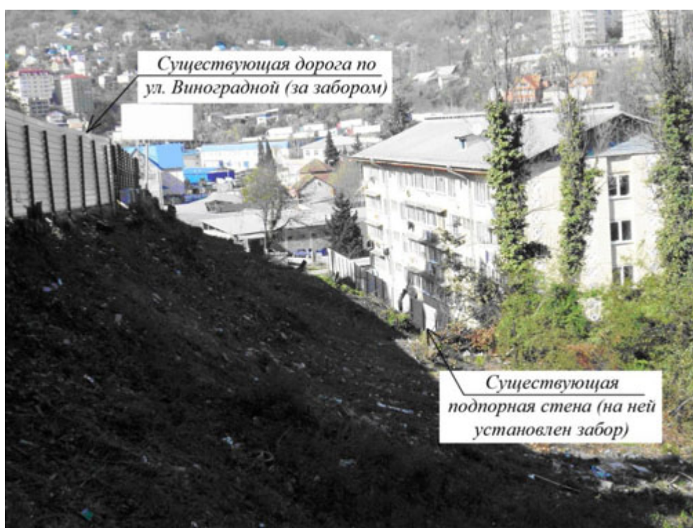
Рис. 1. Общий вид участка вдоль ул. Виноградной. Ось съезда проходит примерно по середине склона
