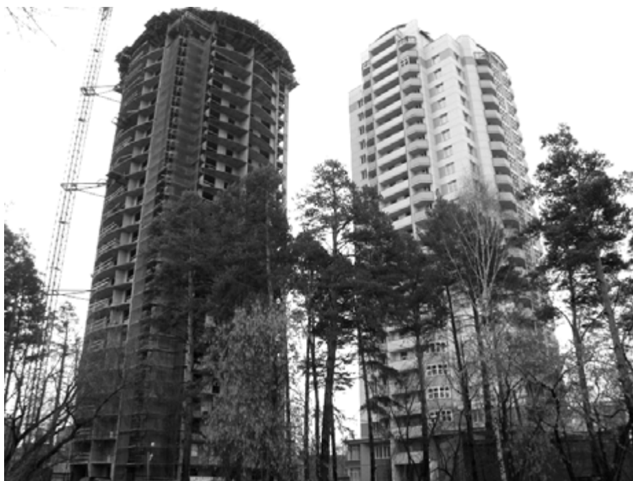
Рис. 5. Близкорасположенные высотные здания по ул. Залесского в г. Новосибирске на фундаментных плитах с инъекционными кондукторами
