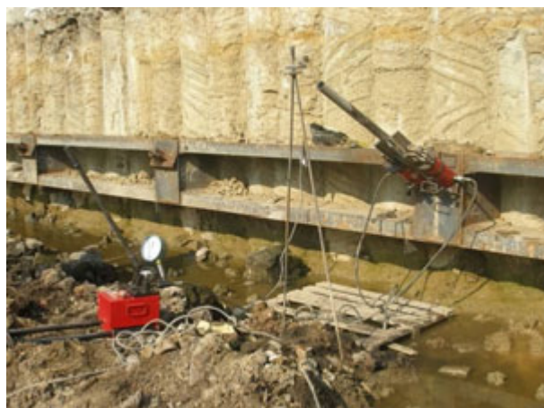
Рис. 7. Фрагмент испытания грунтового анкера
