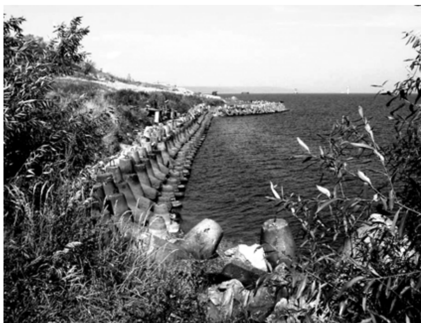
Рис. 4. Деформированная тетраподная наброска вдоль береговой полосы
