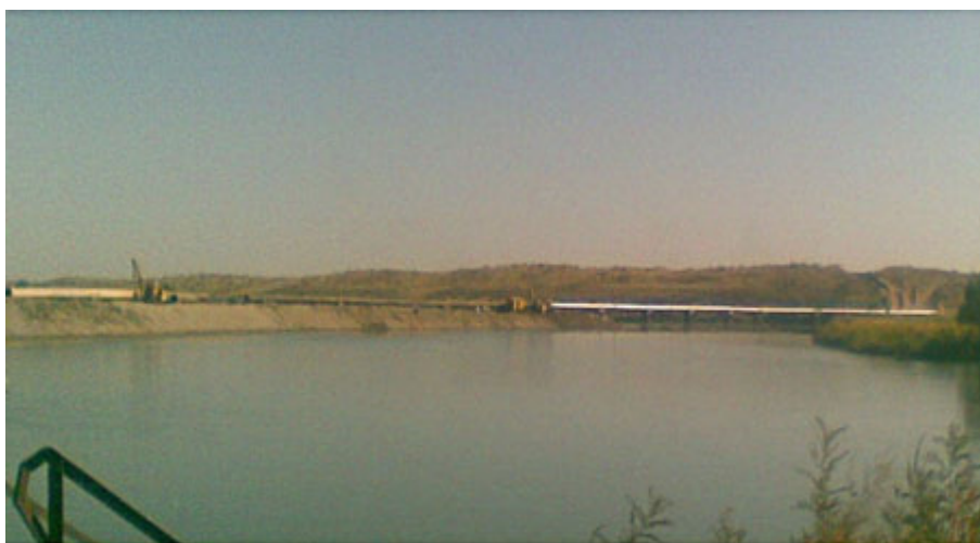
Рис. 3. Общий вид газопровода с фрагментом временной дамбы
