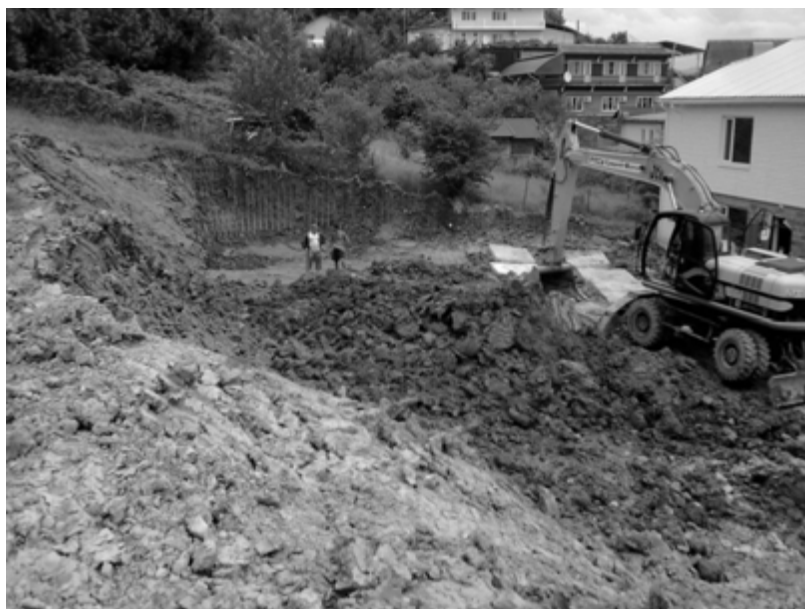
Рис. 5. Устройство дополнительного удерживающего сооружения в языковой части оползня со срезкой наплывшего грунта
