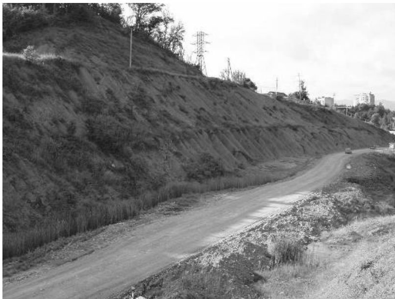
Рис. 1. Общий вид на участок строительства автомобильной дороги в обход г. Сочи, ПК91 – ПК94
