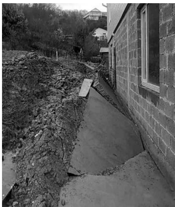
Рис. 3. Выпор грунта в языковой части оползня (деформация отмостки жилого дома)
