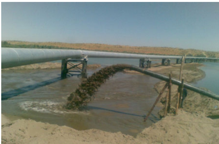
Рис. 2. Процесс намывки временной дамбы при помощи земснаряда
