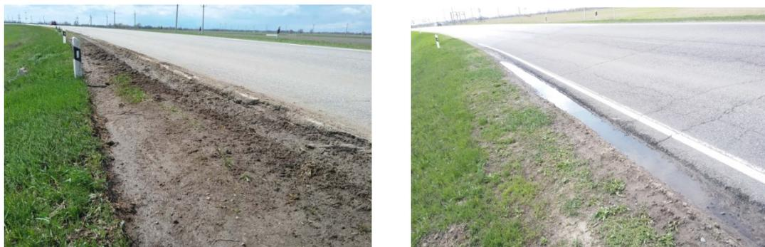
Рис.1. Аварийно опасный криволинейный участок автомобильной дороги с неукреплённой обочиной (фото Скрылёва Г.В.).
