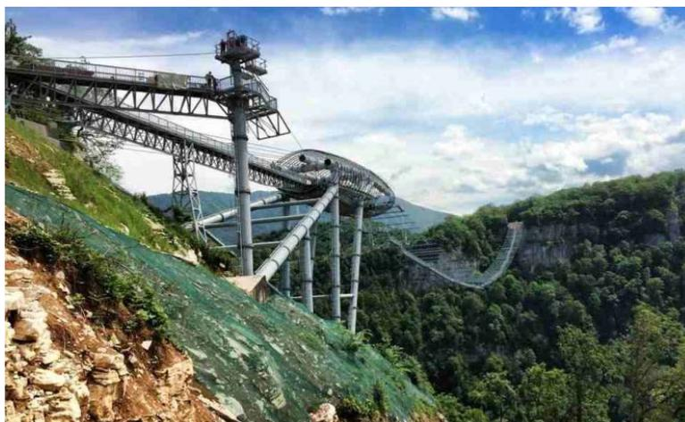
Рис. 4. Подвесной пешеходный мост – аттракцион, включающий: опорную часть смотровой платформы, жёсткий трап, смотровую платформу, сам подвесной пролет с обзорной площадкой, площадки аттракционов, несущие канаты и железобетонные фундаменты. Источник <http://hontos.ru/goroda-i-strani/skybridge-samyiy-dlinnyiy-podvesnoy-peshehodnyiy-most-v-mire>.
