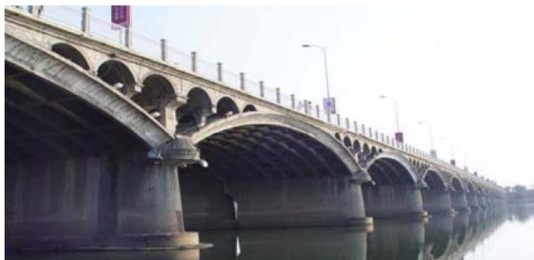
Рис.3. Железобетонный мост с арочными фермами через реку Songhua.
