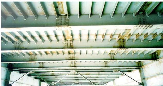
Рис. 3. Следы коррозии на поверхности покровного слоя лакокрасочного покрытия ортотропной плиты на мосту через р. Дон (Источник [6]).
