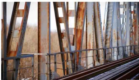
Рис. 7. Нарушение целостности антикоррозионного покрытия
