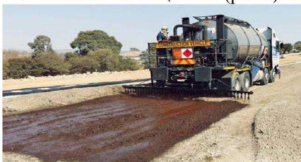
Рис. 2. Химический способ укрепления подвижных песков.
