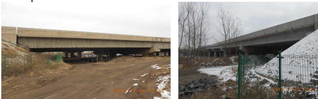
Рис.1. а - мост с разрезными пролетными строениями; б - мост с неразрезными пролетными строениями.
