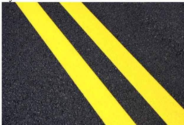
Рис. 3. Разметка, нанесенная с применением спрей-пластика.
