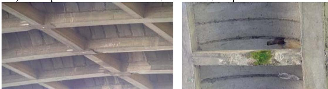
Рис.4. а - повреждения низа арочного свода; б - повреждение горизонтальной связи.
