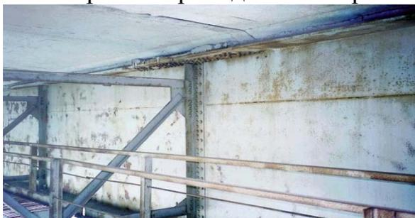
Рис. 2. Коррозия элементов смотрового прохода и поперечных связей на мосту через р. Дон (Источник [6]).
