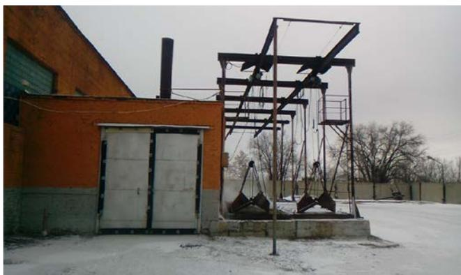
Рис.1. Система водоочистки на автотранспортном предприятии – отстойник.
