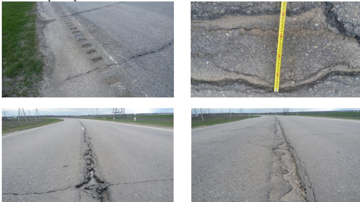
Рис. 3. Дефекты асфальтобетонного покрытия в зоне устройства шумовых полос на автомобильной дороге (фото Скрылёва Г.В.).
