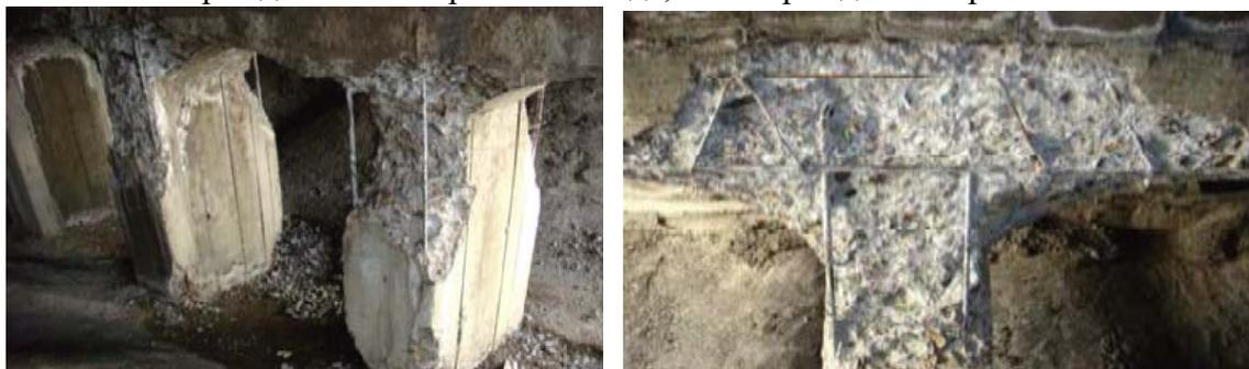
Рис.5. а - повреждение нижних элементов арки; б - коррозионное повреждение стойки.
