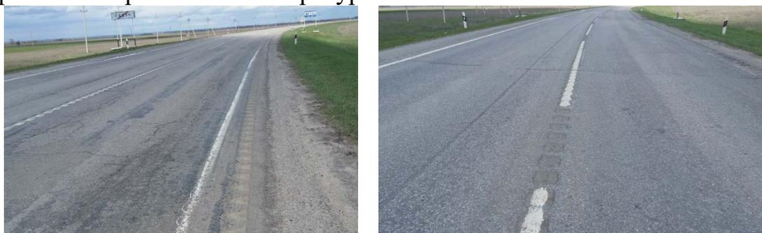
Рис. 2. Использование шумовой полосы совместно с горизонтальной дорожной разметкой на автомобильной дороге (фото Скрылёва Г.В.).
