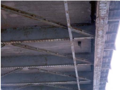
Рис. 4. Коррозионное повреждение ферменного пролетного строения моста через реку Урал (Источник [6]).
