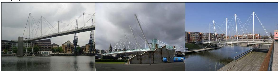
Рис.4 Мосты, с частичным задействованием идеи тенсегрити.
