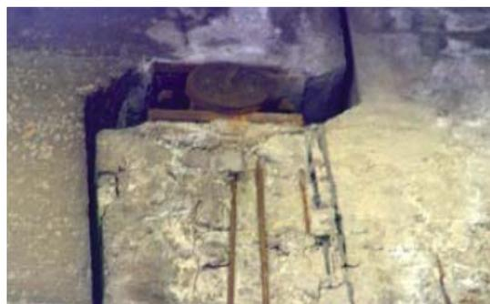
Рис.7. Коррозионное повреждение зоны опирания консоли.
