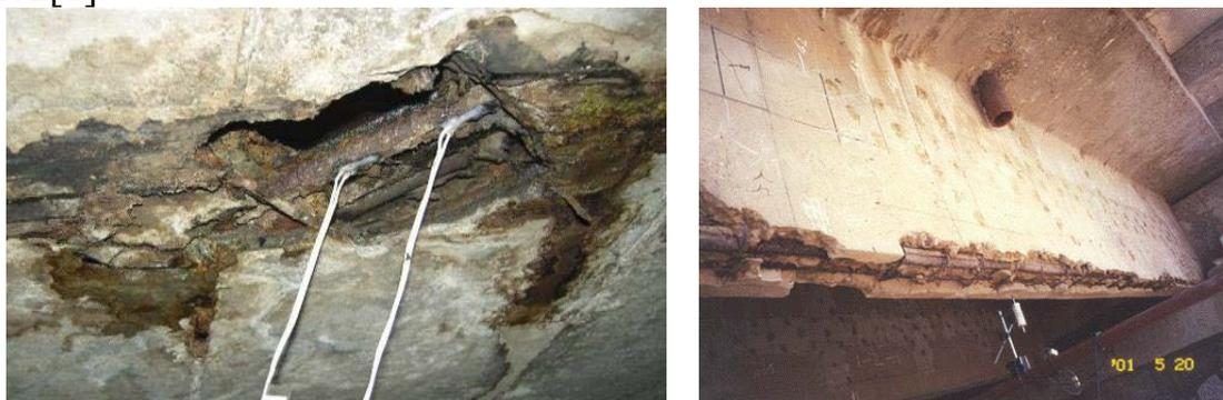
Рис.2.Коррозионные повреждения железобетонных мостовых балок.
