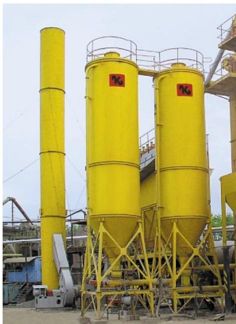
Рис.4 Бункер хранения минерального порошка.
