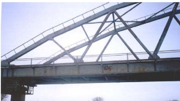
Рис. 5. Коррозионное повреждение ферменного пролетного строения моста через реку Урал (Источник [6]).
