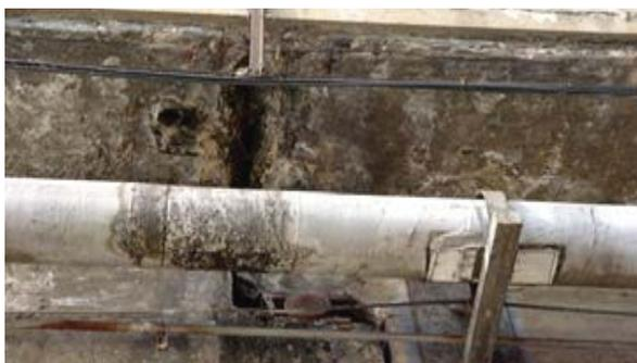
Рис.6. Повреждение дренажа.
