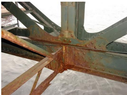
Рис. 6. Коррозия в узле сквозного пролетного строения (Источник <http://prokontrol.ru>).
