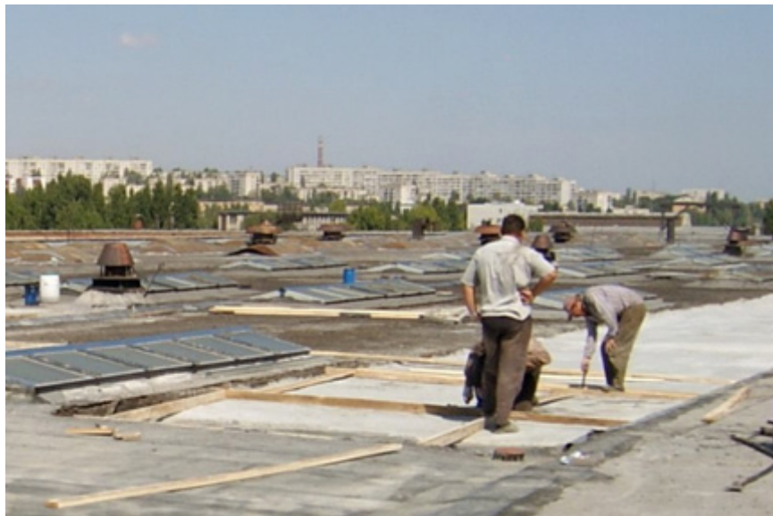
Рис. 2. Заливка пенобетоном покрытия здания речпорта
