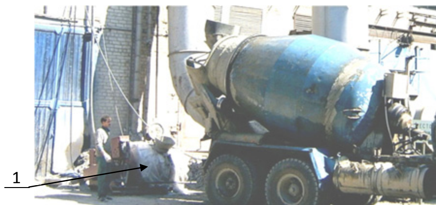
Рис. 1. Мобильная установка для подачи раствора (1) пенобетона на высоту 30-40 метров с использованием автобетоносмесителя для доставки готового пенобетона с территории производственной базы
