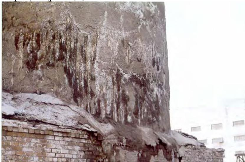
Рис.2. Пластинчатое разрушение защитного слоя выполненного торкретированием. (ОАО «Себряковцемент», 2005г.)
