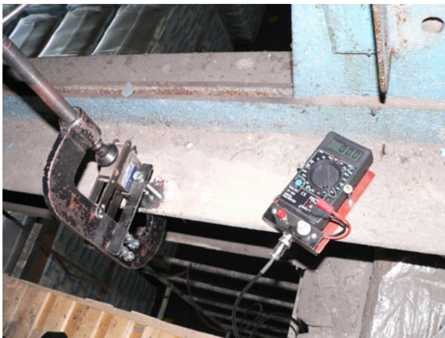
Фото 1. Испытание элемента нижнего пояса стропильной фермы
