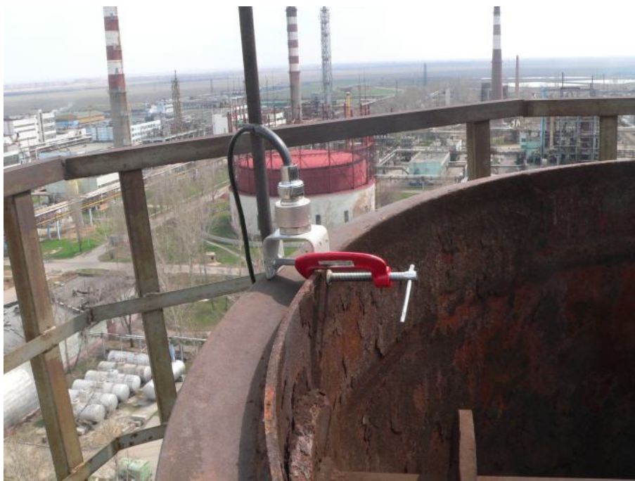
Фото 2. Крепление вибродатчика (акселерометра) наобрезде дымовой трубы на отметке +49,500
