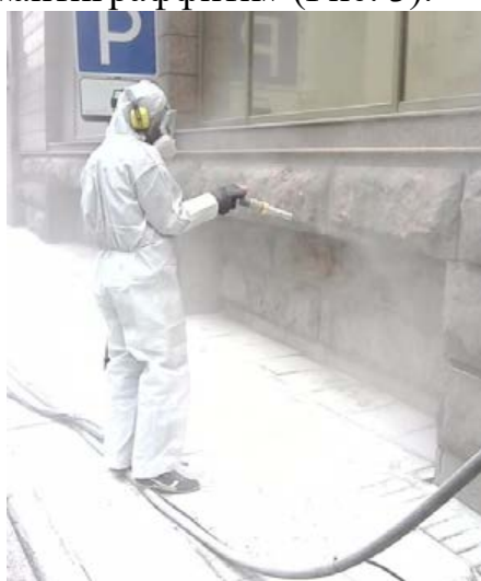
Рис. 3 Нанесение материала со свойствами «антиграффити».
