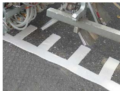
Рис. 2. Рельефная разметка профильного комбинирования «гребешок».
