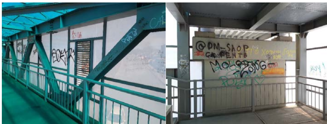
Рис. 2. Внутренние поверхности надземного пешеходного перехода.
