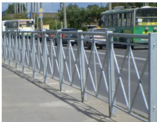
Рис. 6. Ограждение перильного типа.
