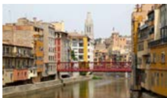
Рис. 5. Мост через реку Оньяр
