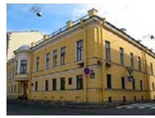
Рис. 5. Дом Монферрана на набережной реки Мойки, 86-88
