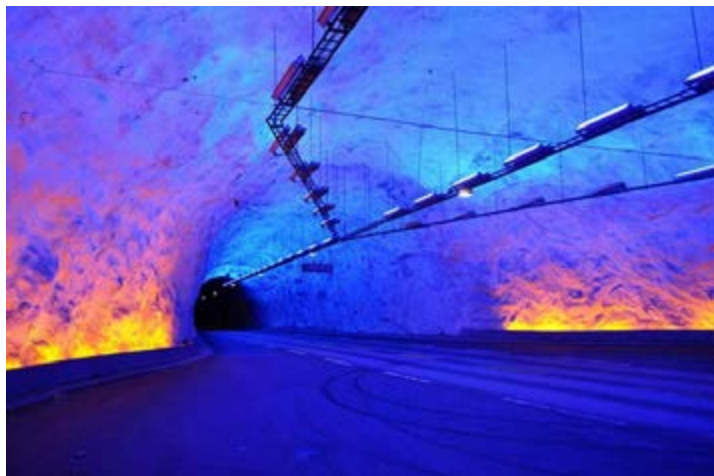
Рис. 1. Внутренняя отделка и освещение Лердальского тоннеля
