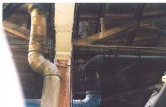
Рис. 2. Воздуховоды опираются на нижний пояс подстропильной фермы
