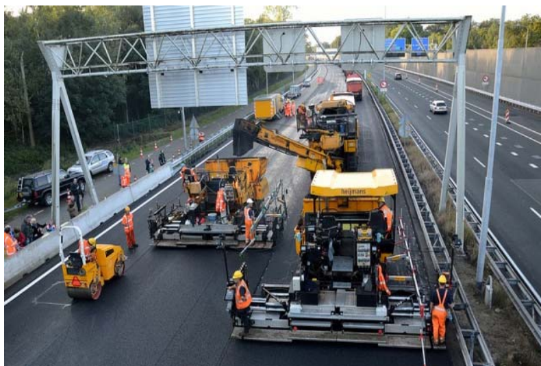
Рис. 1. Применение покрытия ZOAB в г. Вюгте (Голландия)
