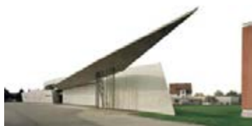
Рис. 4. Пожарная станция компании «Витра». Германия.
