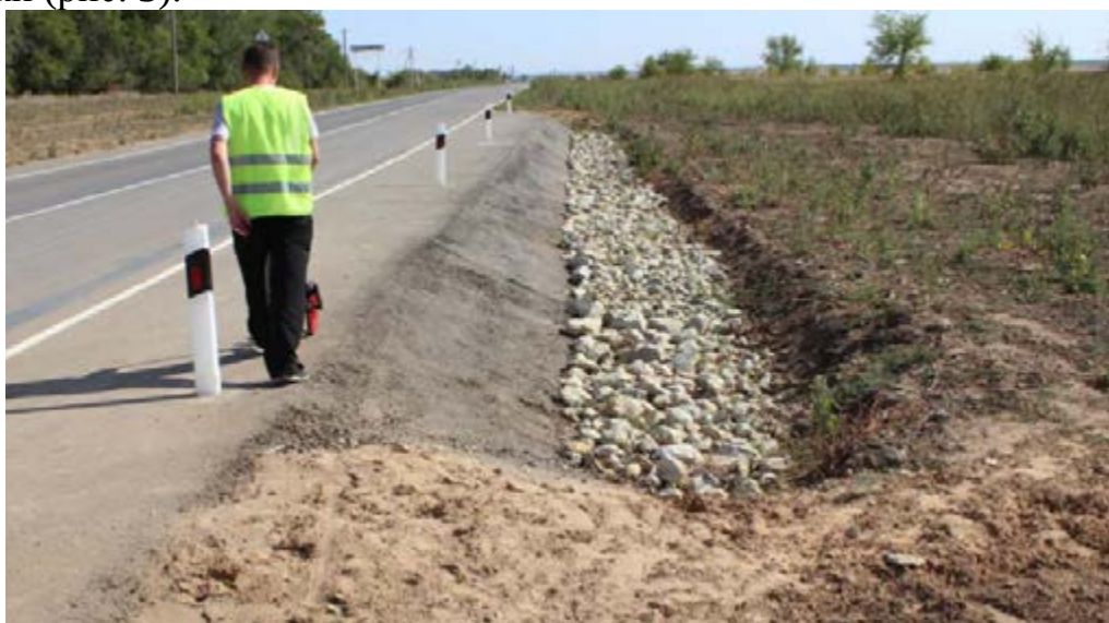
Рис. 3. Переливной лоток на ПК 47+40 - ПК 47+84,5 х. Белокаменка
