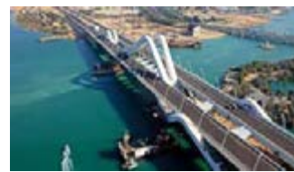
Рис. 9. Мост Шейха Зайда. Абу-Даби, ОАЭ. 2010.
