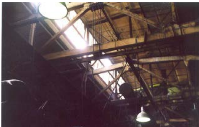
Рис.1. Стропильные фермы корпуса Р-4
