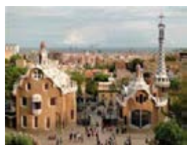
Рис. 4. Парк Гуэля. Два павильона у входа в парк
