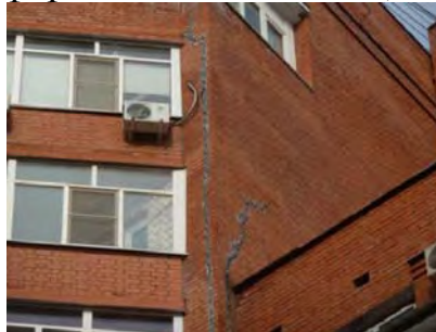
Рис. 2. Вертикальные и наклонные трещины
