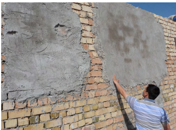
Рис. 1. Отделка стен композитным раствором с комплексной химической добавкой КДж-3
