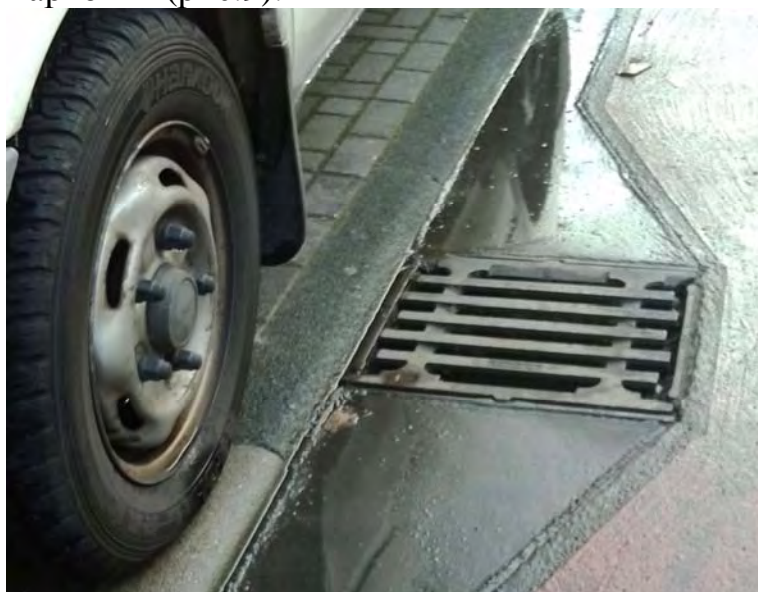
Рис.7 Дождеприемный колодец в зоне парковки
