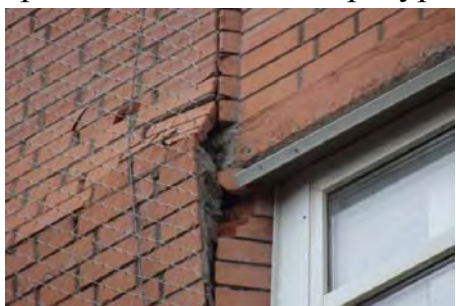
Рис. 1. Потеря устойчивости облицовочного слоя.
