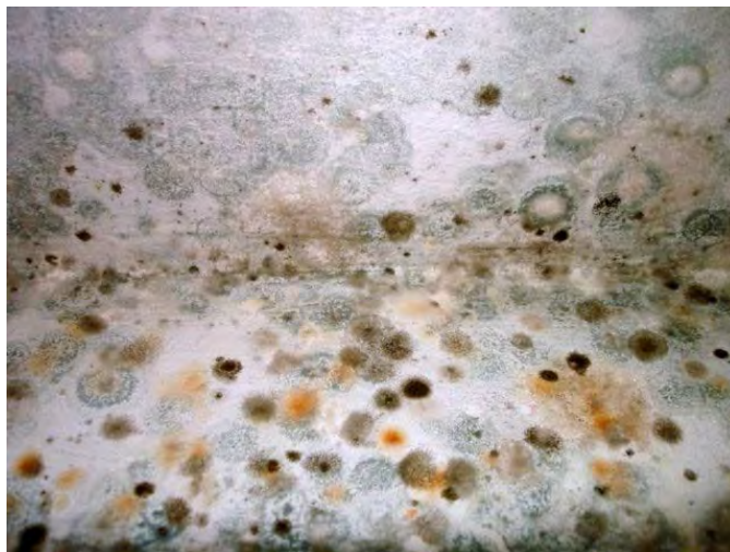
Рис.2. Грибок на бетоне.
