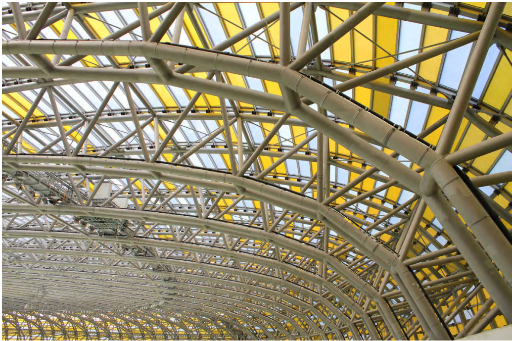
Рис. 2. Консольно-рамные системы навеса над стадионом в Гданьске из труб круглого сечения
