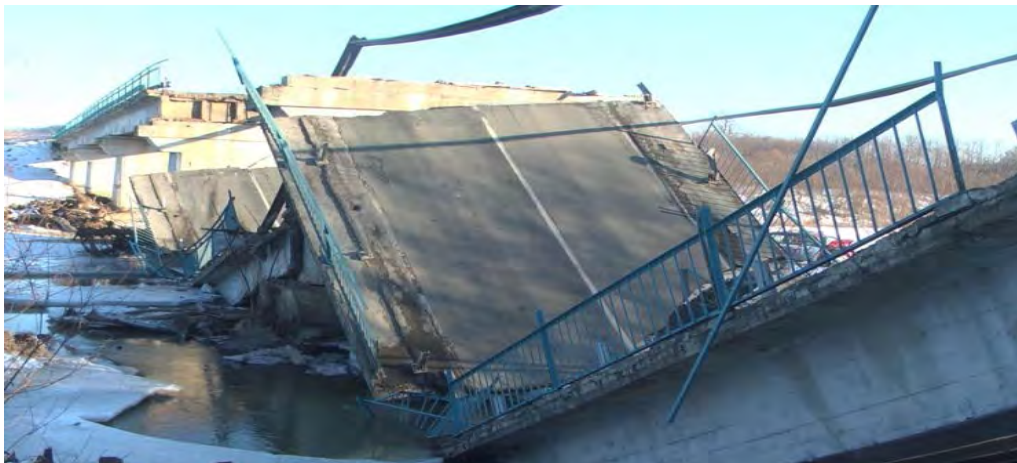
Рис.1 Мост через реку Литовка
