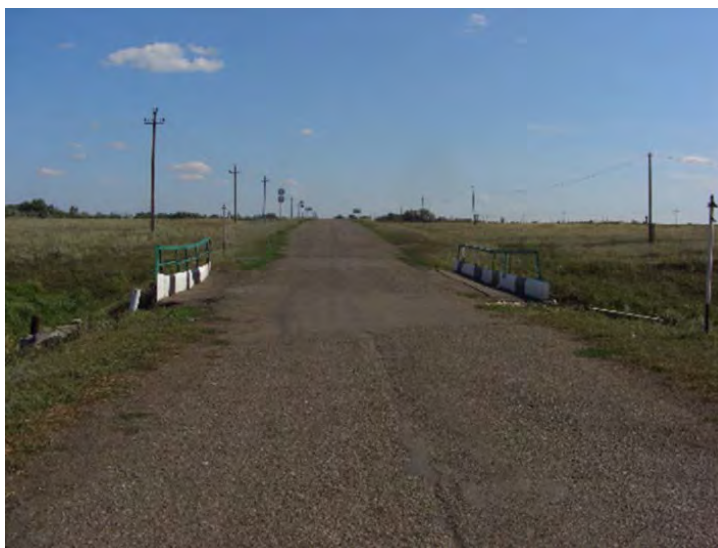
Рис.3. Общий вид проезжей части моста со стороны подхода №1
