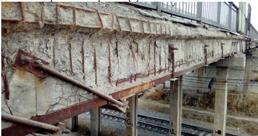
Рис. 1. Разрушение защитного слоя бетона и поражение арматуры коррозией.
