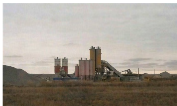
Рис. 3. Переносной цементобетонный завод
