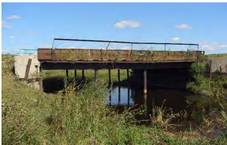
Рис.1. Общий вид моста (с правой стороны) через балку Лог.
