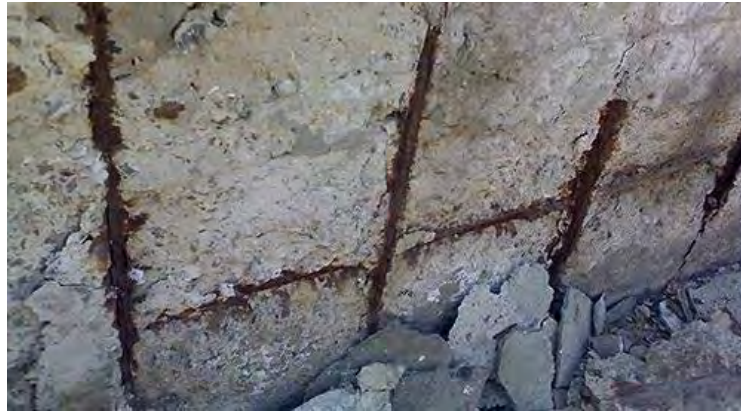
Рис.1. Коррозия железобетона.
