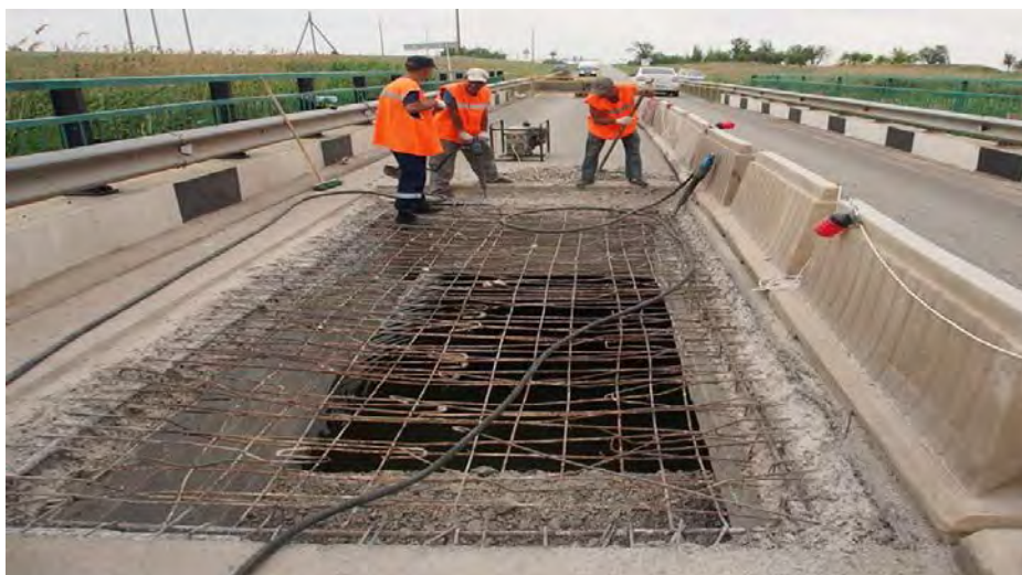
Рис.4 Мост на автодороге Червленое-Калач-на-Дону под Волгоградом
