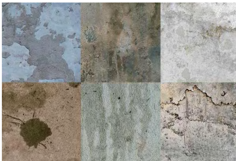
Рис.3. Сульфатная коррозия бетона.
