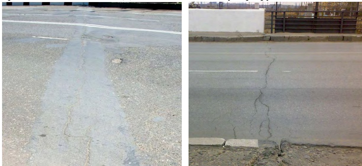
Рис.2. Примеры образования трещин на путепроводах по ул.Толстого на Тулака и Латошинский проездной пункт.
