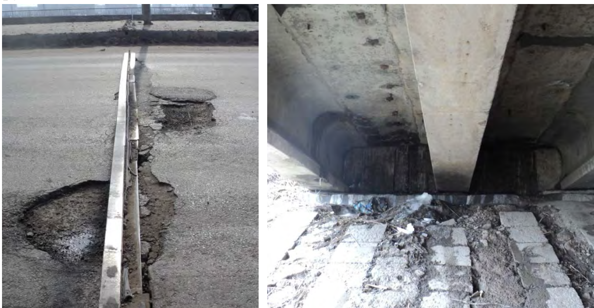
Рис.3. Примеры выбоин и нарушения гидроизоляции на путепроводе на 3-ей Продольной магистрали.
