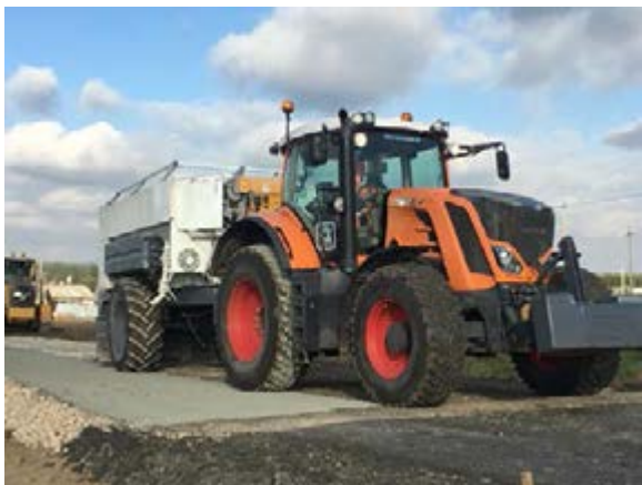
Рис. 3. Распределение портландцемента прицепным цементораспределителем Streumaster SW 10
