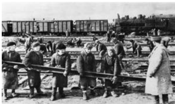
Рис. 2. Укладка рельс на Волжской рокаде.
