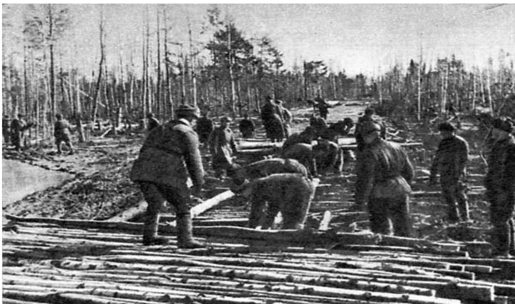
Рис. 2. Прокладка деревянной дороги.
