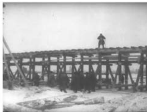
Строительство железнодорожной эстакады
