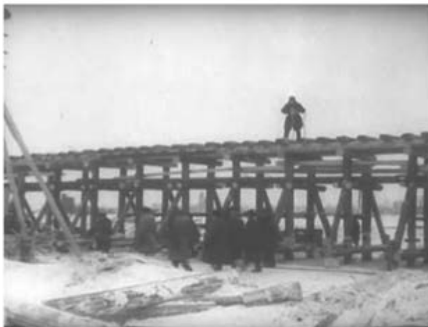
Строительство железнодорожной эстакады
