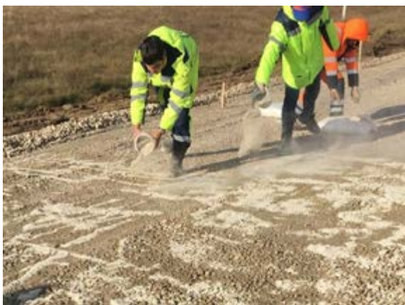
Рис. 5. Распределение добавки цеолит ручным способом
