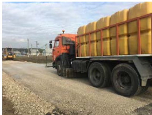
Рис. 4. Розлив воды ПММ на базе КАМАЗ МКДУ-1
