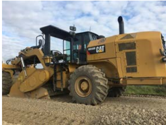
Рис. 6. Смешивание материалов ресайклером CAT RM 500
