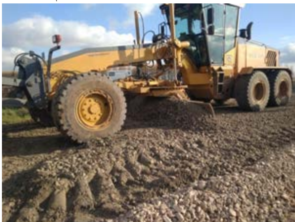
Рис. 1. Планировка щебня автогрейдером VOLVO G 946
