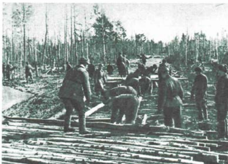
(прокладка деревянной дороги)
