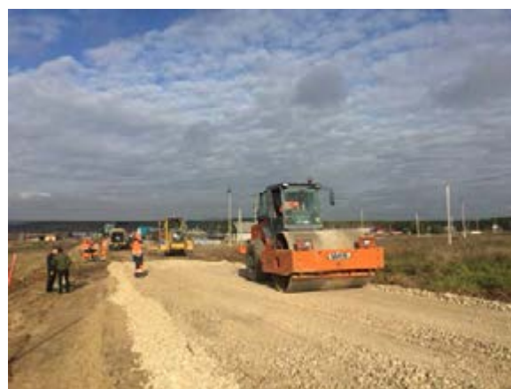
Рис. 2. Предварительная укатка щебня комбинированным катком HAMM 3518
