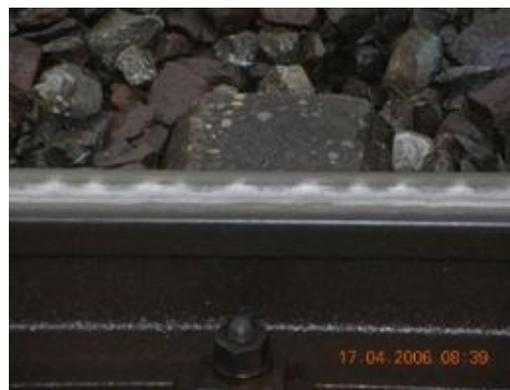
6. Schienenabsorber – устройство для поглощения шума на рельсах железной дороги. Сокращает шум до 2-4 (дБ). Принцип работы всех «Absorber» можно объяснить на примере фужера. Если вы держите фужер за ножку и стучите по нему карандашом он будет звенеть тише, чем если вы возьмёте за фужер
