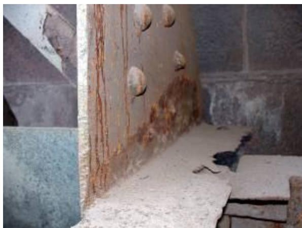
Рис. 1. Узел примыкания фасонки стойки к нижнему поясу фермы.
