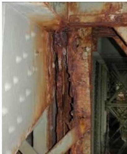
Рис 2. Вид на шарнирный узел балочно-подвесного пролетного строения фермы. Тяж, обеспечивающий передачу усилий и перемещений от подвесного пролетного строения, интенсивно корродирует.
