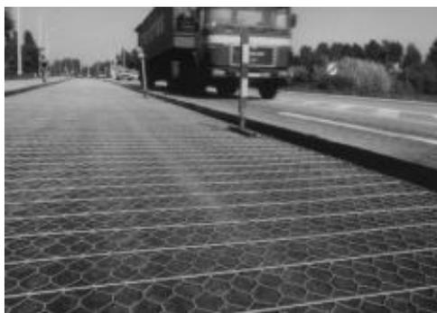
Рис. 1 Применение стальной арматурной сетки для армирования покрытия
