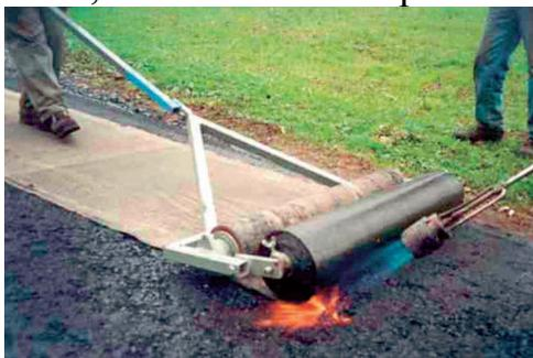
Рис. 2 Армирование асфальтобетонного покрытия
