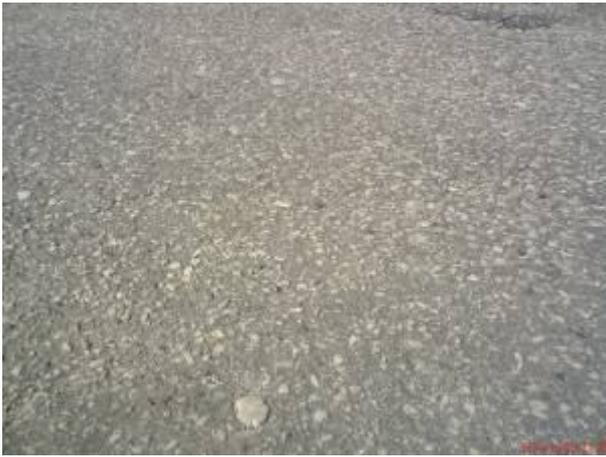
Фото 2. Применение в асфальтобетоне битума БНД 60/90 ОАО «Саратовский нефтеперерабатывающий завод»
