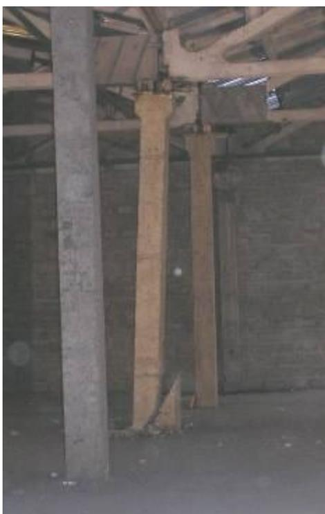
Рис.1. Срезанная железобетонная колонна
